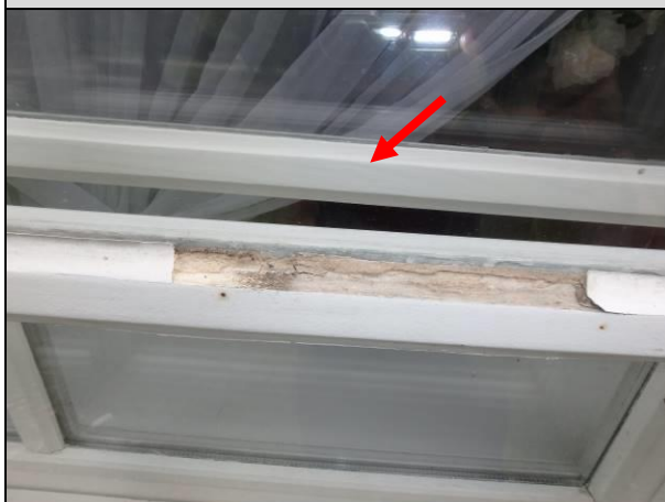
Fot. 41. Przykładowe ubytki kitu szklarskiego.
