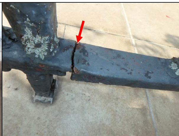
Fot. 34. Przykładowe uszkodzenie przęsła balustrady. Tu pęknięcie przęsła na skutek korozji.
