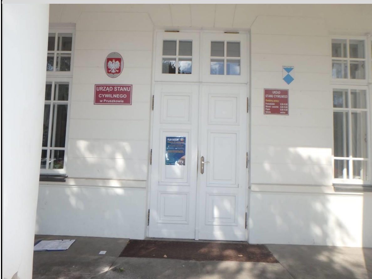
Fot_13. Widok wejścia drzwi wejściowych do budynku. Drzwi drewniane płycinowe z naświetlami. Naświetle ze szprosami.
