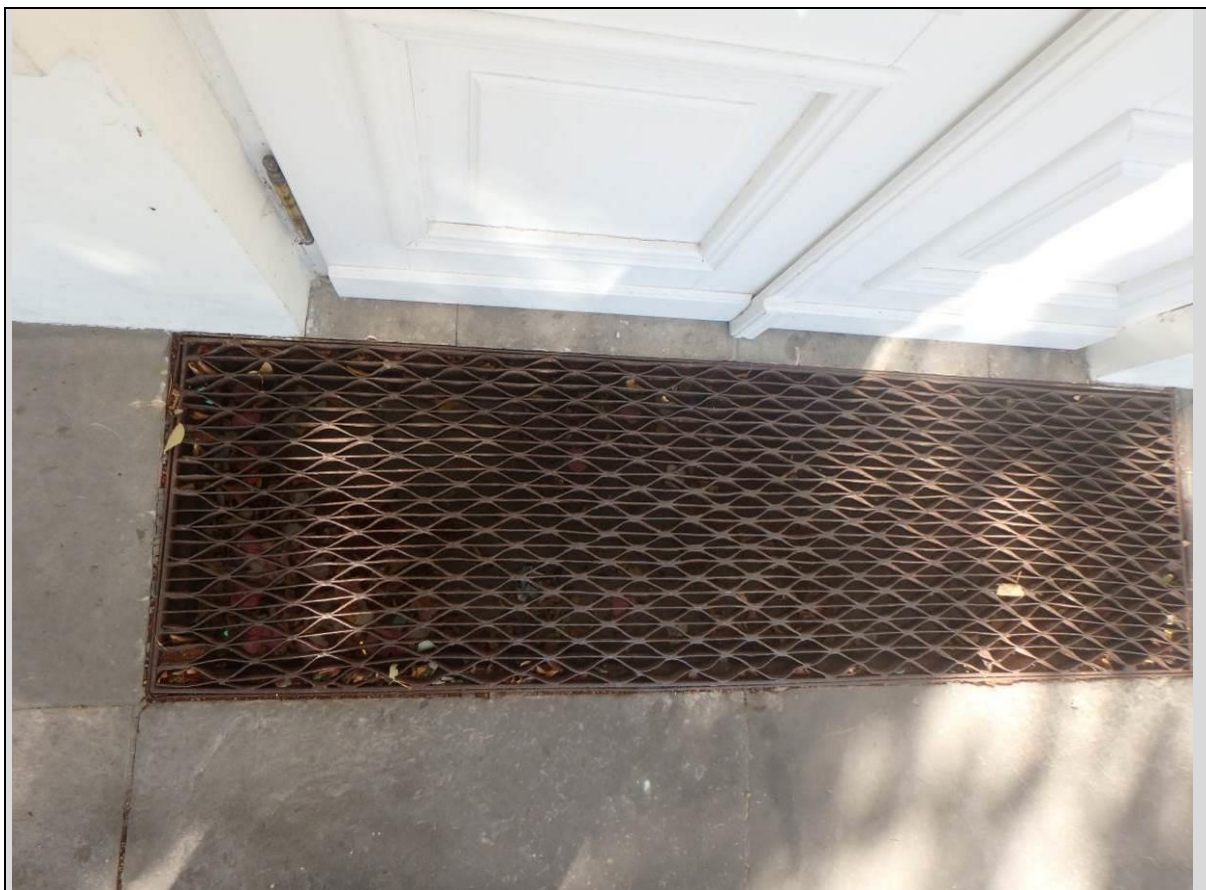
Fot. 22. Widok stalowej wycieraczki pokrytej korozją
