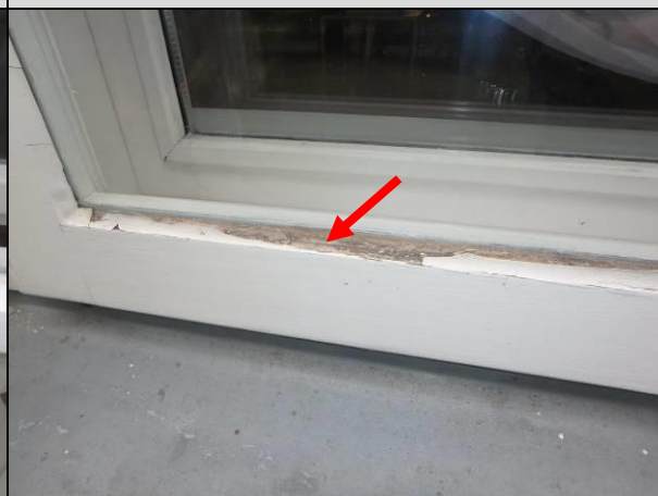
Fot. 41. Przykładowe ubytki kitu szklarskiego.
