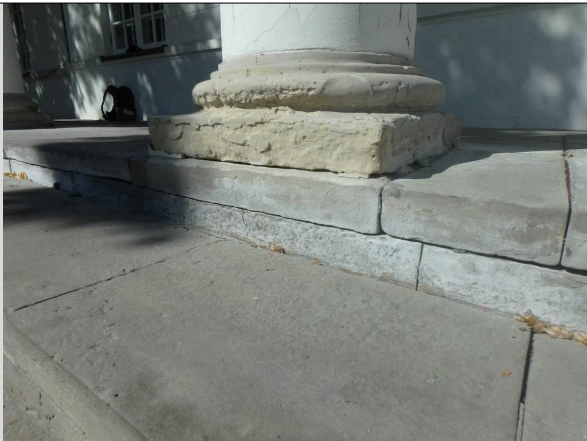
Fot. 18. Widok zdegradowanej podstawy słupa wykonanej z piaskowca. Na podstawie słupa widoczne ubytki korozyjne.
