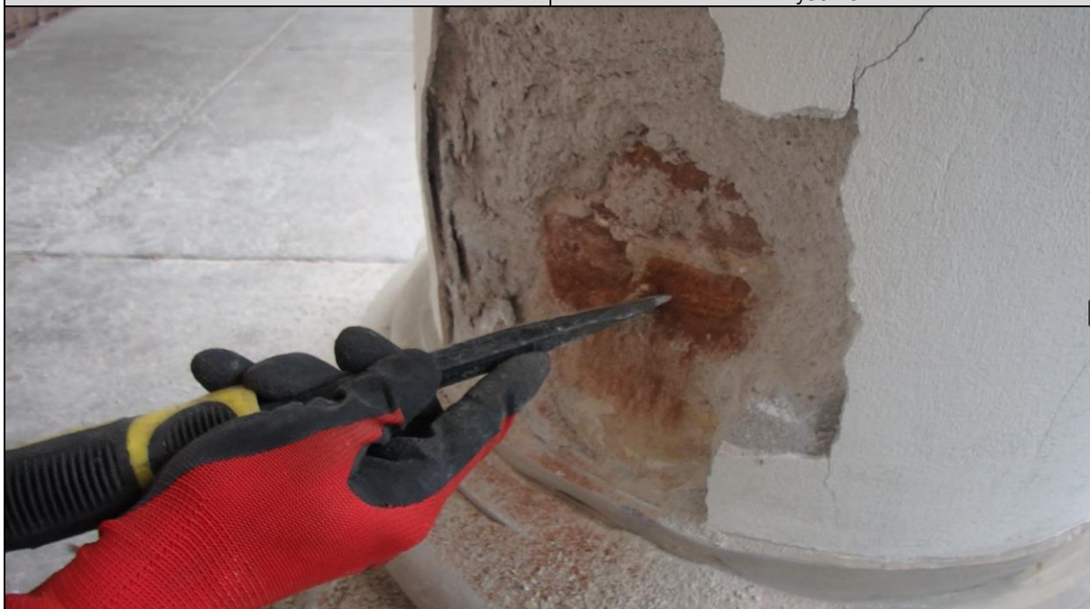
Fot. 01_3. Struktura cegły w miejscu odkrywki osypująca się nienośnie. Zasolenie struktury cegły \geq 1\% -bardzo wysokie.
