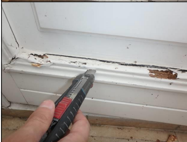
Fot. 39, 40. Przykładowe, występujące miejscowo zbutwiałe elementy drewniane
