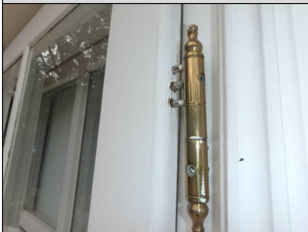
Fot. 41. Przykładowe pęknięcie ramy okiennej przy zawiasie.
