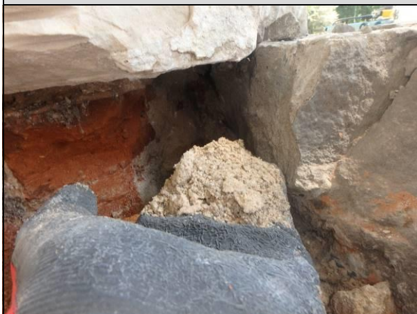
Fot_02_9, 02_10. Przykład całkowicie zwiertzałej spoiny.
