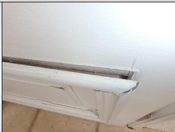
Fot. 41. Przykładowe uszkodzenie ramki mocującej ozdobną płycinę.
