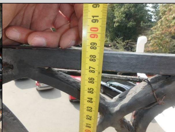
Fot. 37, 38. Wysokość balustrady ok 89cm.
