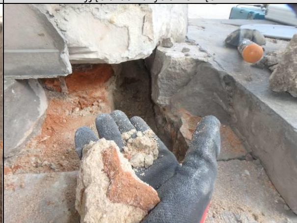
Fot_02_9, 02_10. Przykład całkowicie zwiertzałej spoiny.
