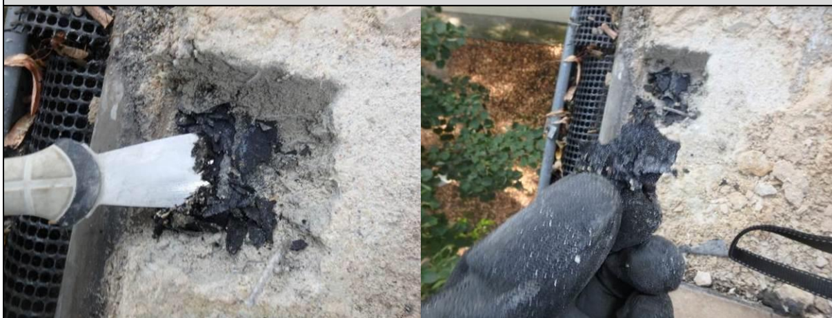
Fot. 04_5, 04_6. Zastosowana izolacja bitumiczna wątpliwej jakości – „krucha” - nieelastyczna.
