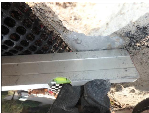
Fot 05_9. Krawędziowa obróbka blacharska wykonana ze spadkiem „do wewnątrz” budynku – rozwiązanie uniemożliwiające prawidłowe odprowadzenie wody – nieprawidłowo.
