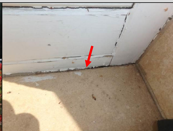
Fot. 32. Brak doszczelnienia strefy styku posadzki z drzwiami balkonowymi.
