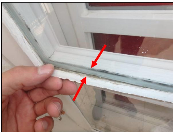
Fot. 43, 44. Przykładowe uszkodzenie ramki mocującej szybę okienną
