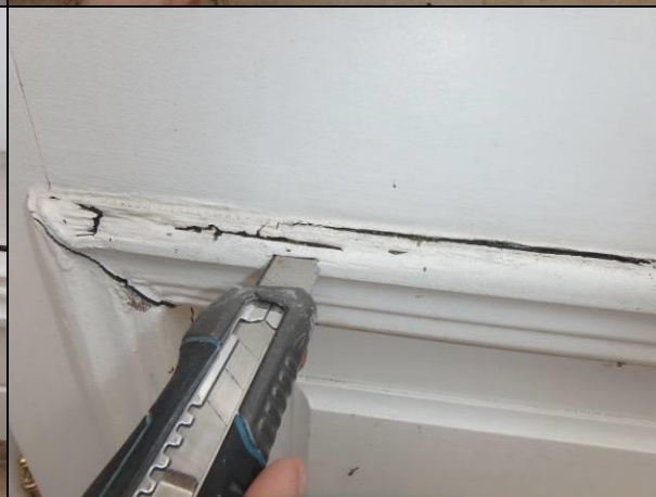
Fot. 39, 40. Przykładowe, występujące miejscowo zbutwiałe elementy drewniane
