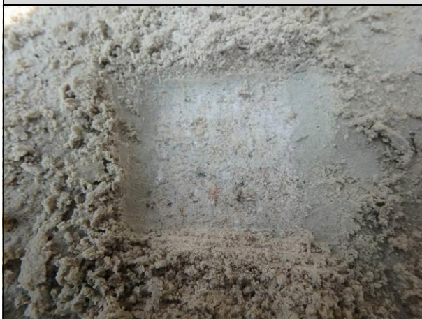
Fot 05_5. Pod płytką szlichta cementowa niezabezpieczona izolacją podpłytkową
