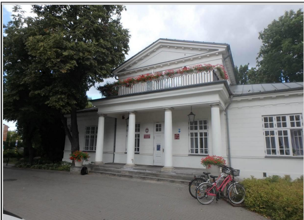
Fot_12. Widok wejścia głównego do budynku. Schody wraz z podestem wykonano z płyt z piaskowca. Słupy konstrukcyjne wykonane jako murowane, tynkowane.
