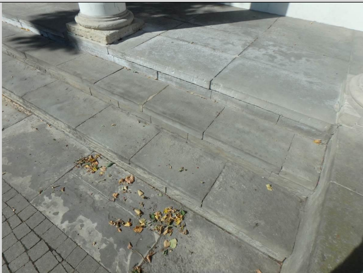
Fot. 19. Widok zanieczyszczonej, przebarwionej posadzki podestu/schodów zewnętrznych wykonanej z płyt z piaskowca. Na powierzchni płyt z piaskowca widoczne wysolenia oraz ubytki korozyjne.
