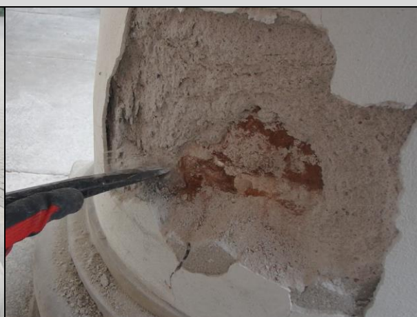
Fot. 01_2. Tynki w miejscu odkrywki osypujące się nienośnie. Zasolenie struktury tynków \geq 1\% -bardzo wysokie.
