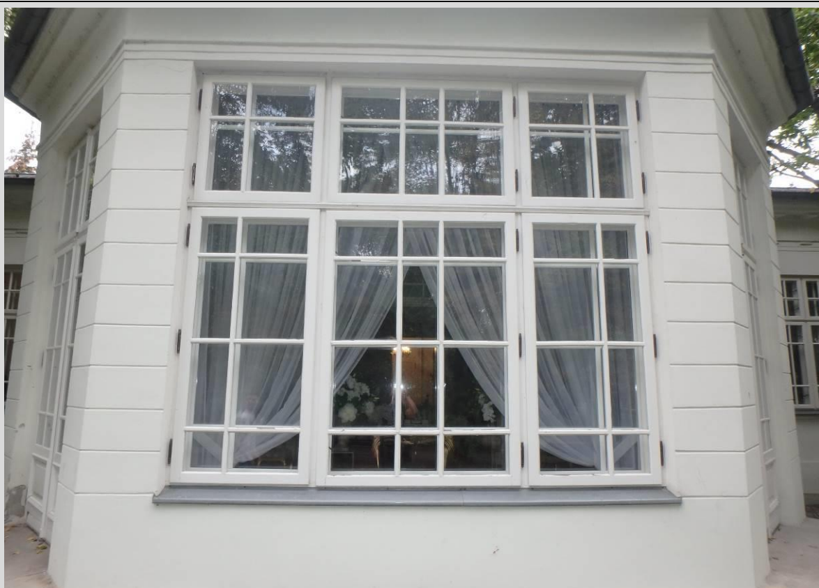
Fot_15. Widok przykładowej stolarki okiennej. Okna drewniane, skrzynkowe z płycinami i szprosami, wykonane na wzór pierwotnych. Okna ościeżnicowe (okna polskie) podwójne, szyba zewnętrzna pojedyncza, szyba wewnętrzna podwójna. Okucia mosiężne.
