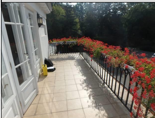
Fot. 31. Istniejące okładziny ceramiczne balkonu w dużej mierze odspojone nienośnie.
