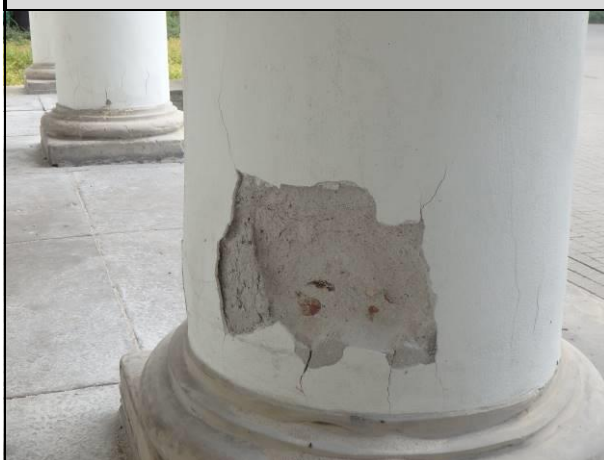
Fot. 01_1. Widok miejsca odkrywki. Widoczne spękania i odspojenia tynków..
