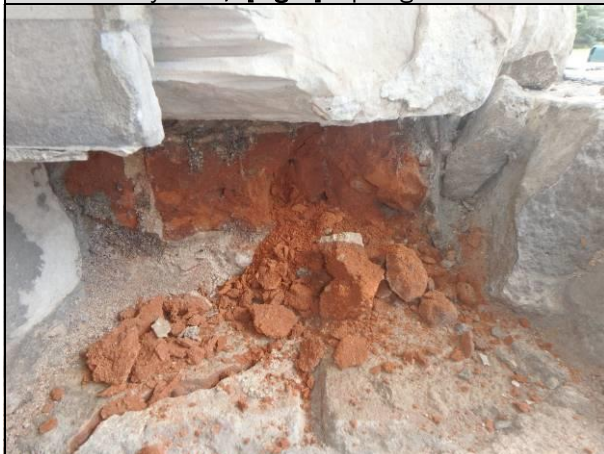
Fot_02_7. Cegła wymurowana pod podstawą słupa zmurszała, krucha, o obniżonych parametrach nośności.
