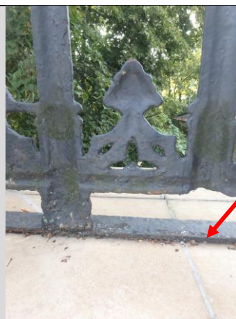
Fot. 30. Warstwy posadzkowe wykonane „na styk” z dolną krawędzią balustrady – brak możliwości swobodnego odprowadzenia wody opadowej.
