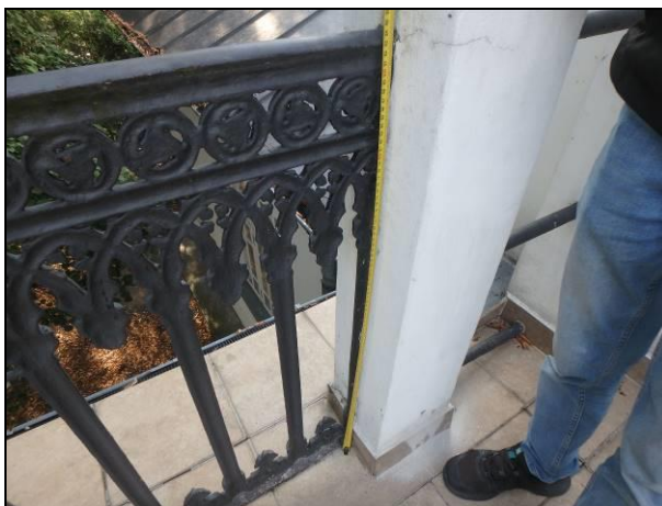
Fot. 29. Wysokość balustrady ok 94cm.
