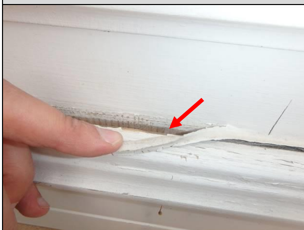
Fot. 41. Miejscowe wtórne naprawy przy pomocy poliuretanowych mas uszczelniających..
