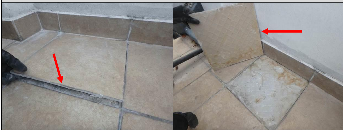
Fot 04_1, 04_2. Płytki wraz z zaprawą klejącą nienośna – możliwa do zdjęcia w całości. Brak izolacji podpłytkowej
