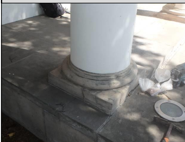
Fot_02_1, 02_2. Podstawa słupa z wyraźnymi pęknięciami strukturalnymi.
