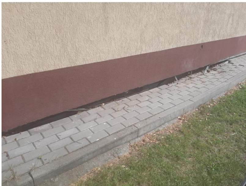
Zdjęcie nr 4 – opaska z kostki betonowej
