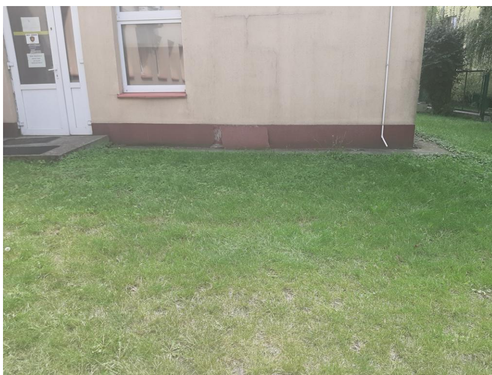
Zdjęcie nr 6 – zniszczony tynk mozaikowy cokołu
