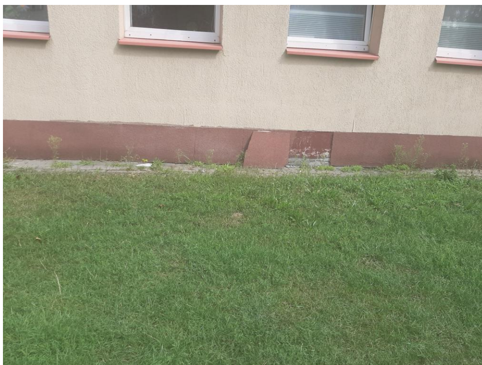
Zdjęcie nr 5 – zniszczony tynk mozaikowy cokołu
