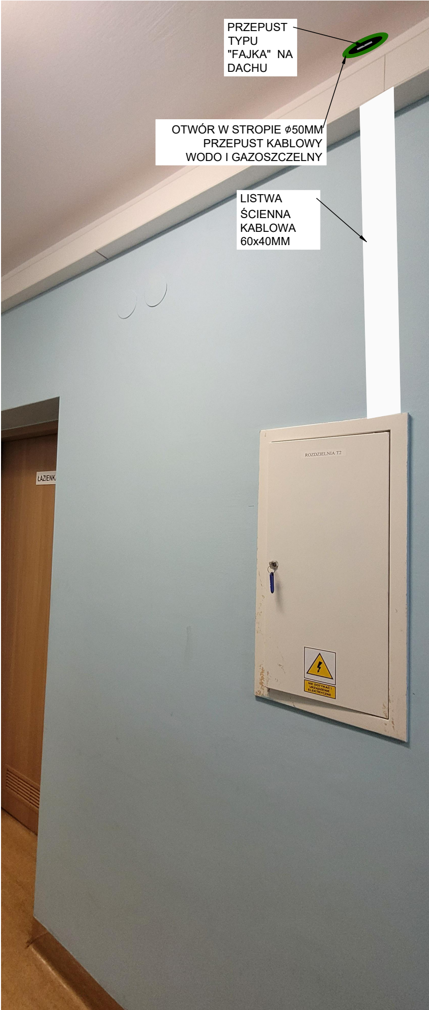
DETAL TRASY KABLOWEJ NA KORYTARZU PRZY ROZDZIELNICY T2 - BUDYNEK NR 2
