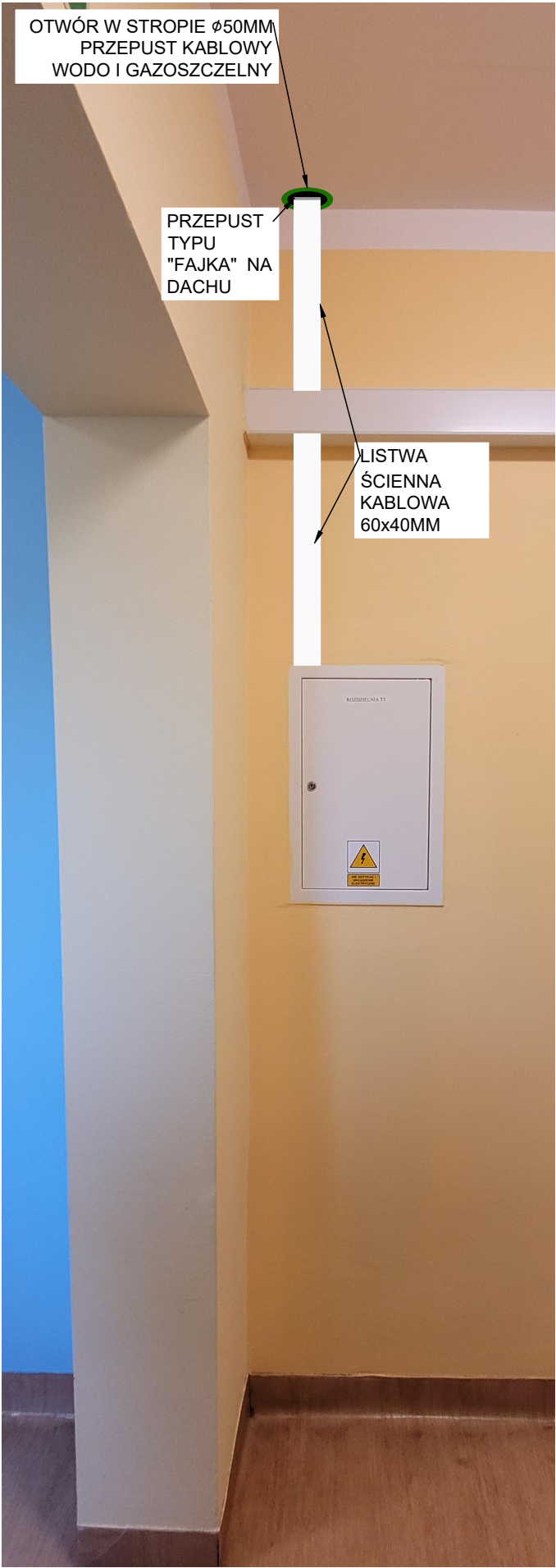
DETAL TRASY KABLOWEJ NA KORYTARZU PRZY ROZDZIELNICY T3 - BUDYNEK NR 3
