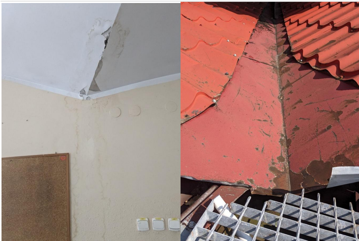
Zdjęcie nr 32- zawilgocona ściana w sali spotkań Zdjęcie nr 33- miejsce nieszczelności dachu
