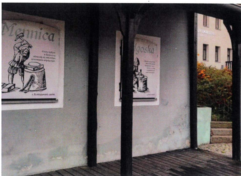
Fot. nr 5 Ściana zewnętrzna zachodnia. Widoczne zawilgocenia i ubytki tynku w dolnej części ściany
