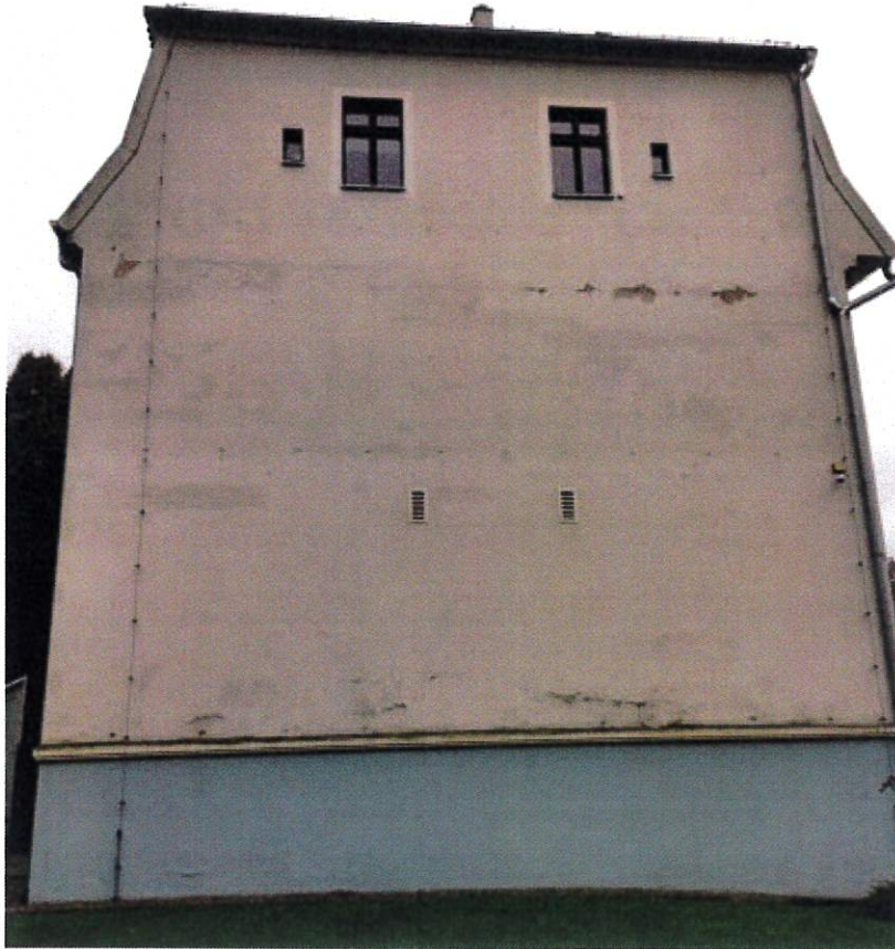
Fot. nr 4 Elewacja północna
