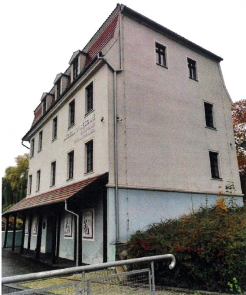
Fot. nr 3 Elewacja południowo-zachodnia
