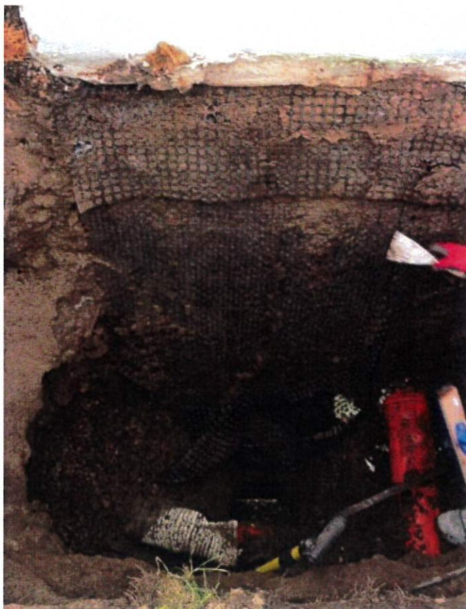
Fot. nr 18 Odkrywka nr O1. Woda gruntowa 15cm poniżej odsadzki fundamentu. Widoczne połączenie rur drenarskich
