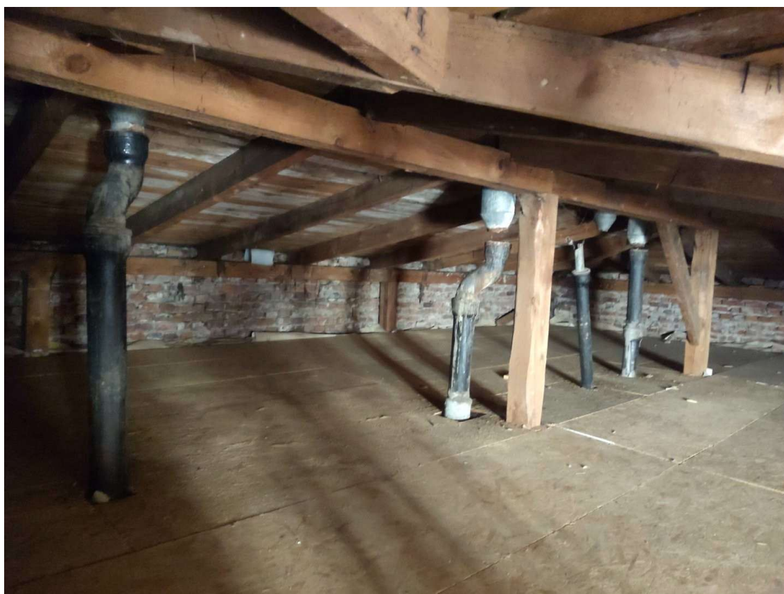
Brak połączenia pionów kanalizacji z wywiewkami dachowymi
