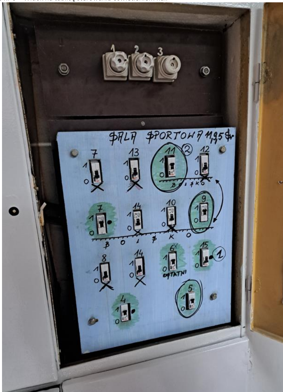
Zdjęcie nr 6 – Widok na tablicę sterowania oświetleniem hali
