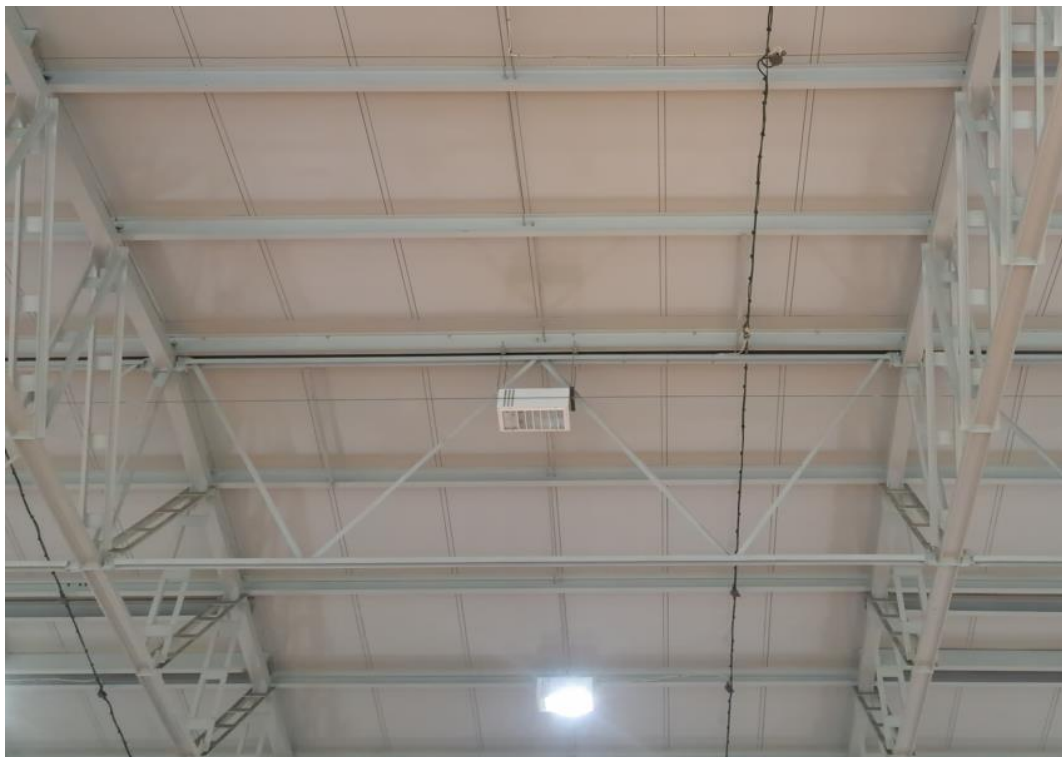
Zdjęcie nr 3 – Widok na oprawy zwieszane z konstrukcji
