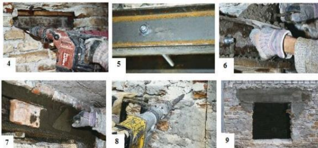
Fot. 1. Przykładowy sposób wykonania nadproża z zastosowaniem belek stalowych (materiały pochodzą z bazy strony murator-dom.pl).
