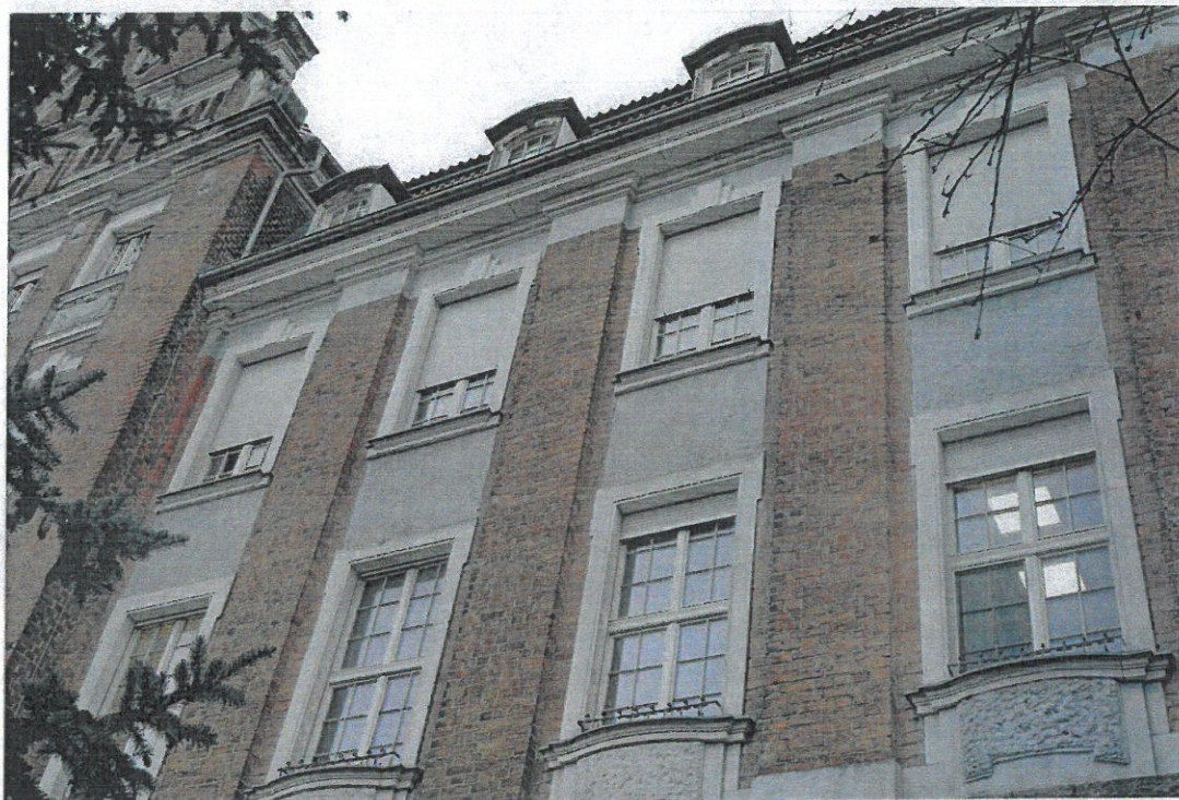
Widoczne wtórne tynki w płycinach między oknami.
