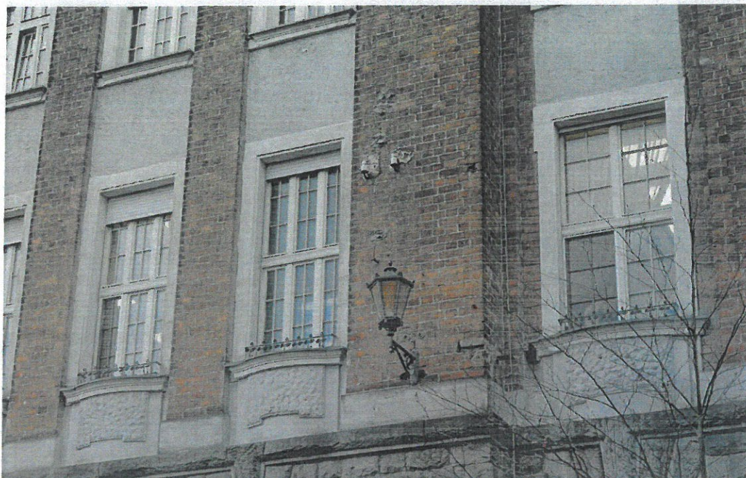
Fragment ściany, widoczne dawne przyłącza
