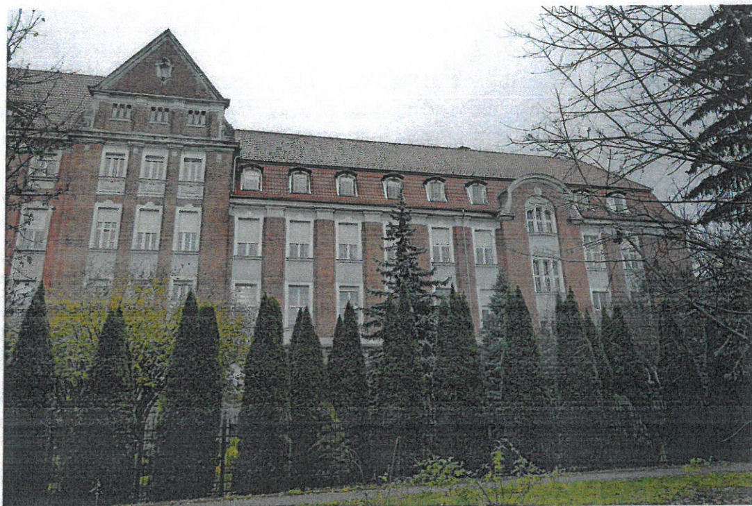
Widok części elewacji oraz ryzalitu od ul. M Reja- fragment budynku należący do Urzędu Marszałkowskiego w Olsztynie
