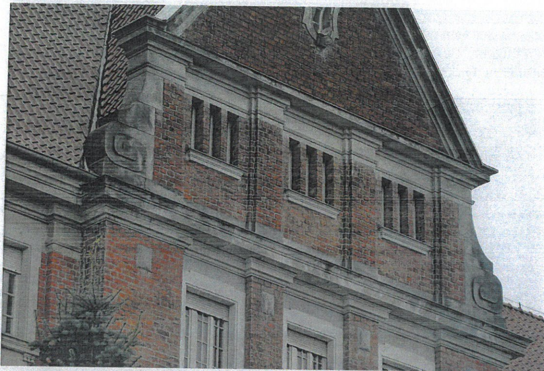
Widok fragmentu elewacji- smółkowe nawarstwienia na kamieniu i ceglach, poniżej widoczne tynki oryginalne od al. Piłsudskiego i ich brak na elewacji od ul. M Reja.
