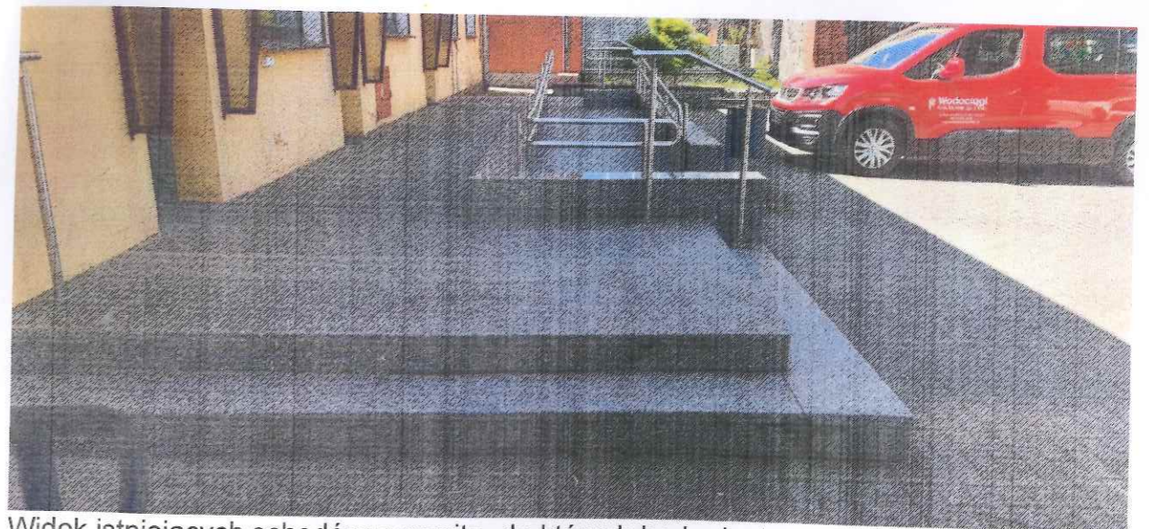
Widok istniejących schodów z granitu, do których będą dostosowane schody projektowane
