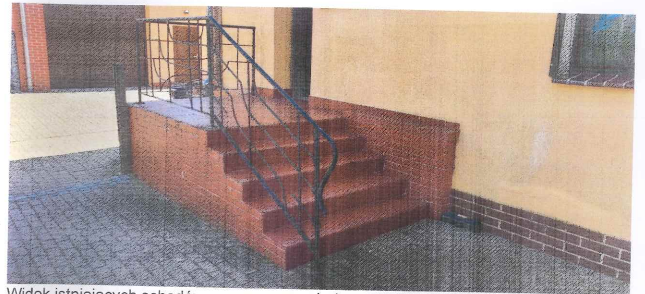
Widok istniejących schodów przeznaczonych do rozbiórki
