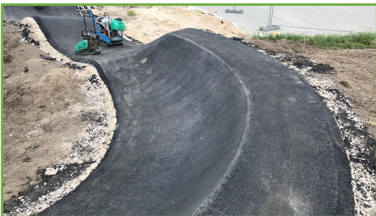
Prawidłowo wykonana nawierzchnia asfaltowa – jednorodna i gładka.
