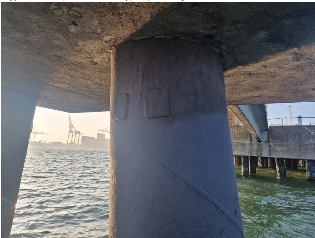
Zdjęcie 2. Widok płaskowników do wykorzystania przy pomiarach skuteczności OK
