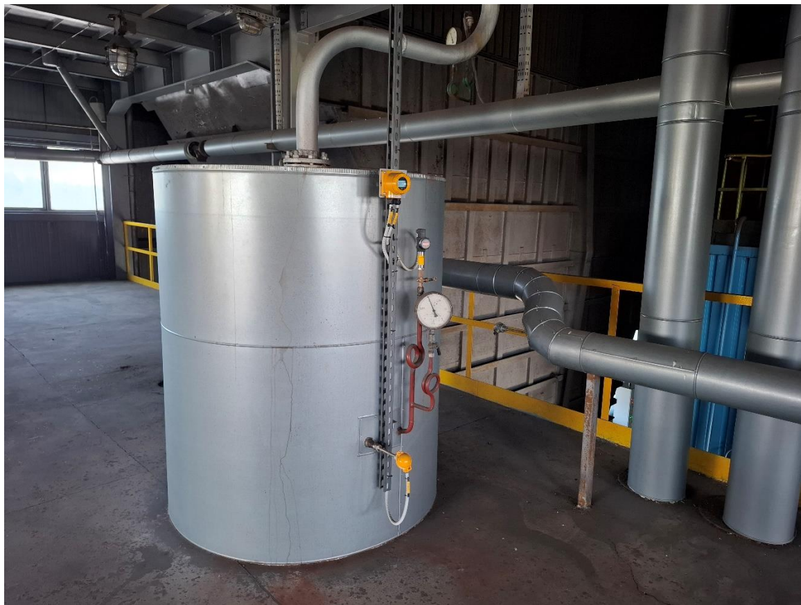
Fot. 5. Fragment orurowania obecnego układu odgazowania wody
