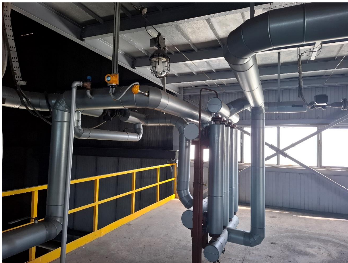
Fot. 5. Fragment orurowania obecnego układu odgazowania wody
