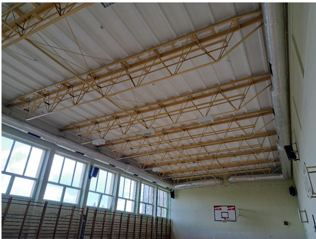
Zdjęcie nr 2 – Widok 2. na rozmieszczenie i montaż opraw oświetlenia podstawowego
