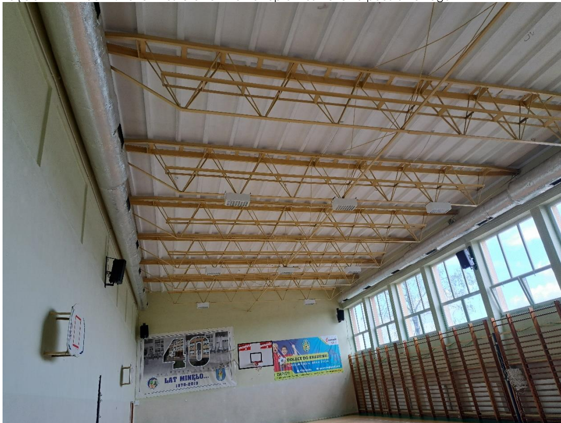
Zdjęcie nr 2 – Widok 2. na rozmieszczenie i montaż opraw oświetlenia podstawowego
