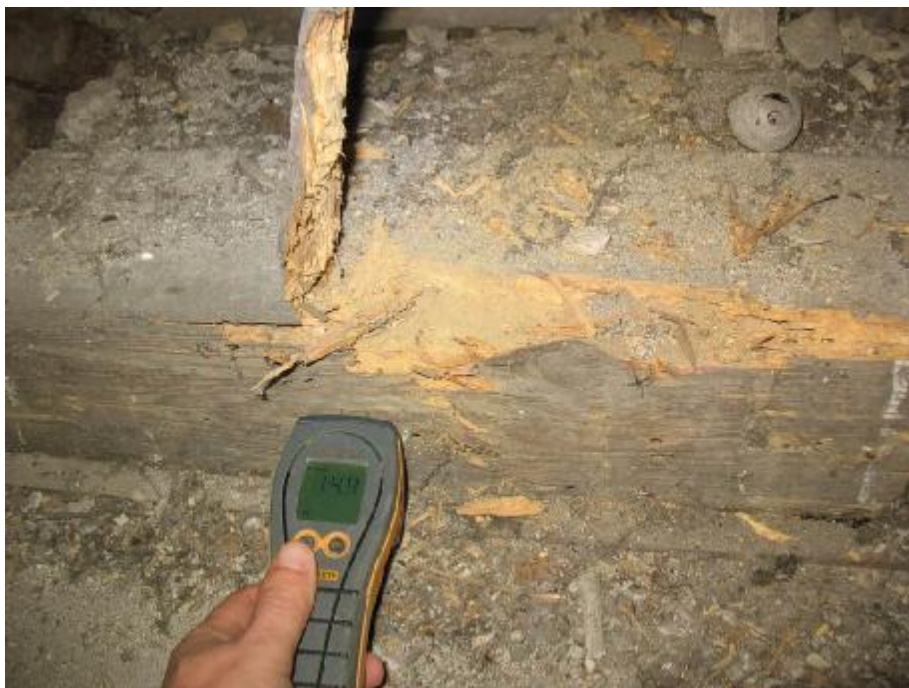
Fot.27 Widok na uszkodzoną murłatę o wymiarach 17x12cm . Uszkodzenie korozja biologiczną jest wynikiem działania owadów – szkodników drewna.
