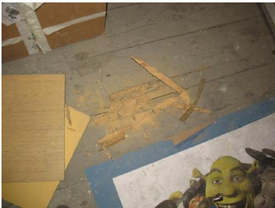
Fot.18 Posadzka jest porażona biologicznie przez działanie owadów – szkodników drewna. Podłoga drewniana do wymiany na nową. Po rozbiórce deskowania należy sprawdzić stan techniczny stropu drewnianego.
