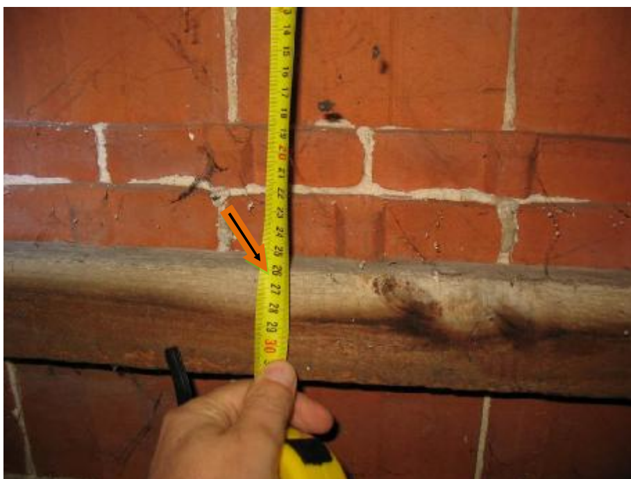
Fot.11 Rozstaw łąt co 26cm. Pokrycie z dachówki ceramicznej na łątach.
