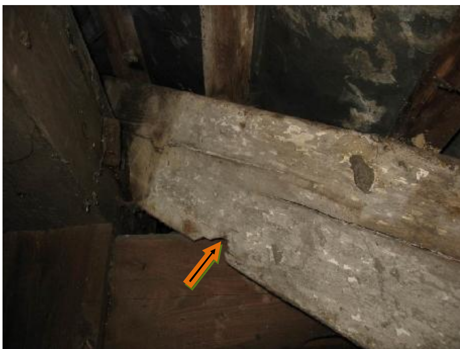
Fot.7 Krokiew koszowa posiada ślady uszkodzeń na przekroju. Strzałka wskazuje ubytek drewna.
