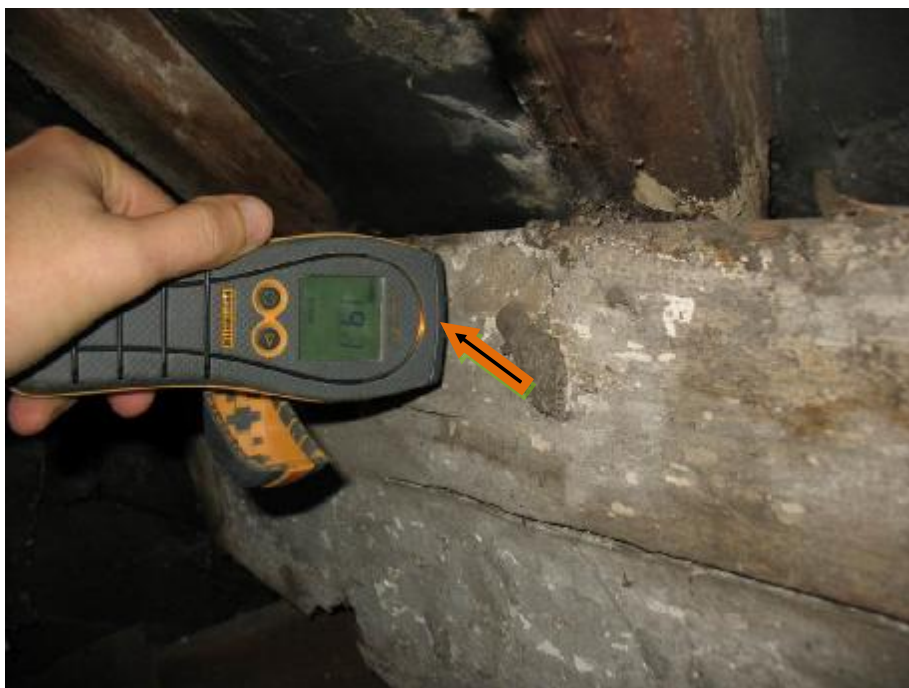
Fot.6 Krokiew przy kalenicy posiada ponadnormatywne zawilgocenie (strzałka wskazuje żółte wskazanie). Badanie wykonano miernikiem Protimeter Surveymaster. Odczyt 19,1 % > 15%
