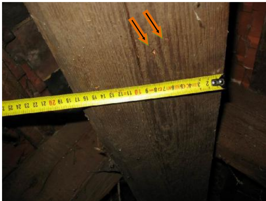
Fot.13 Płatew o szerokości 18cm. Strzałki pokazują otwory okrągłe i owalne świadczące o działaniu korozji biologicznej w wyniku działania szkodników – owadów drewna.
