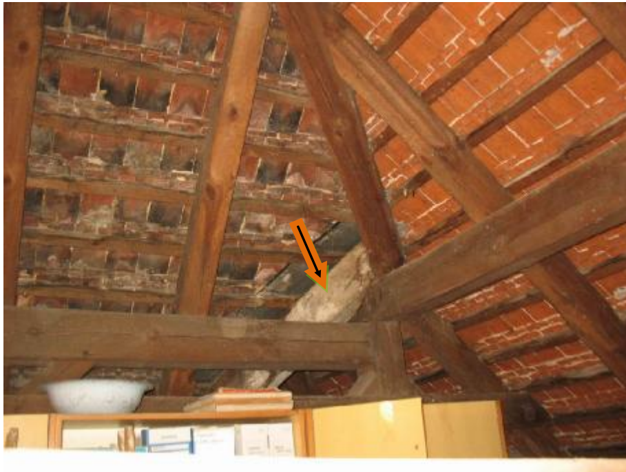
Fot.3 Widok ogólny na lokalizację krokwi koszowej
