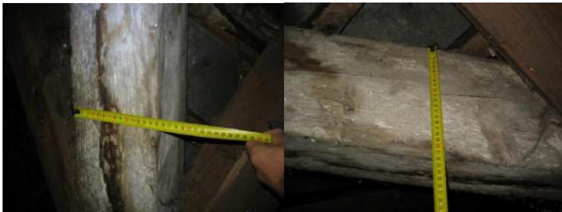
Fot.4,5 Krokiew koszowa o wymiarach 14x22cm posiada ślady korozji biologicznej
