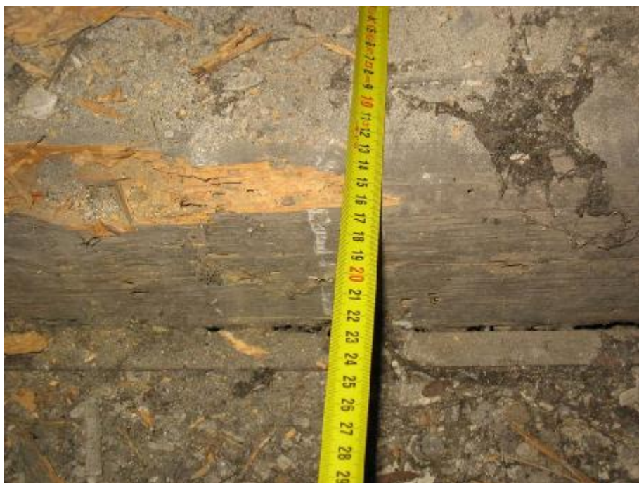
Fot.28 Widok w zbliżeniu na uszkodzenie. Widoczne owalne otwory świadczą o żerowaniu drewna larwami Spuszczela pospolitego. Charakterystyka owadów została opisana w dalszej części opinii
