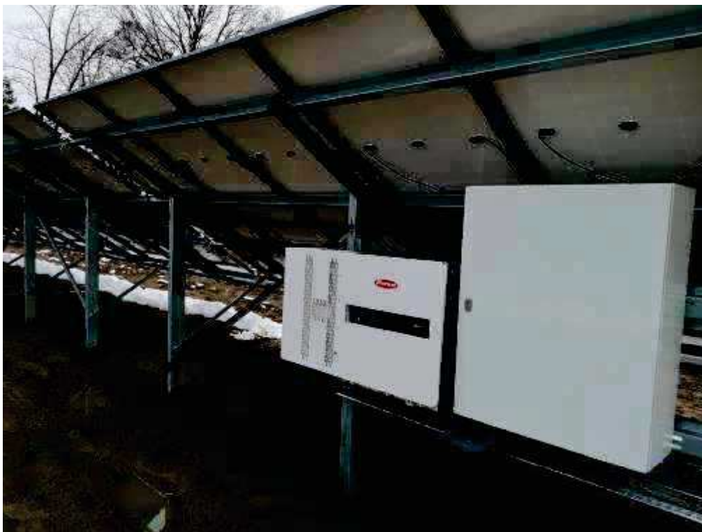
Zdjęcie nr 2 – przykładowy sposób montażu falownika na konstrukcji wolnostojącej
