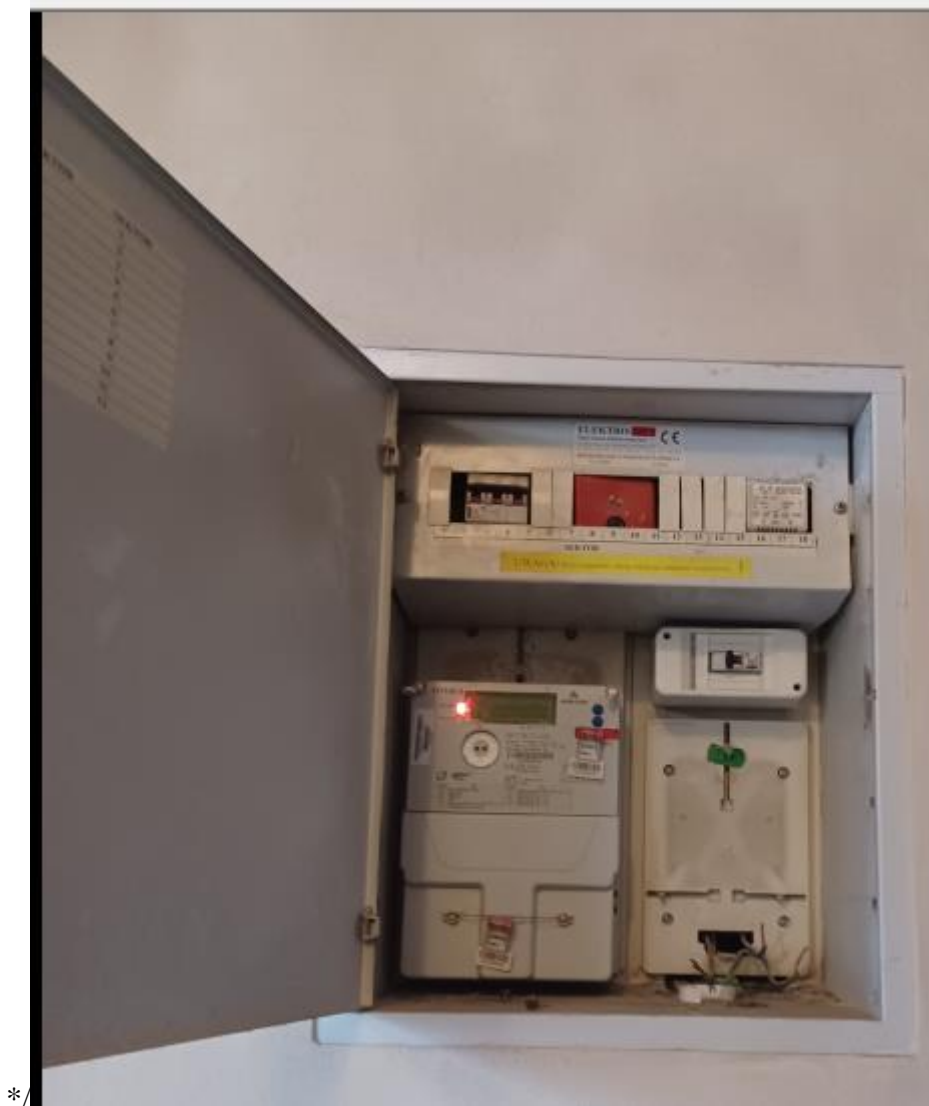
Rys. 3 Istniejący układ pomiarowy lokalu użytkowego
