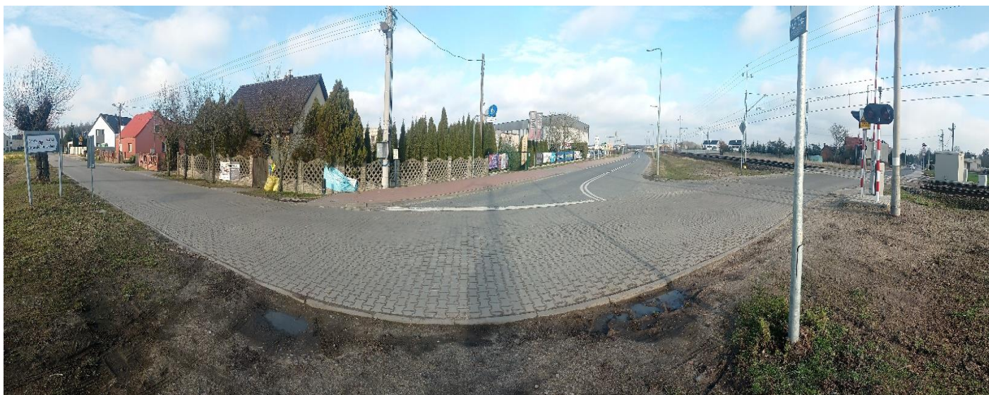
Fot.3. Skrzyżowanie wyniesione z ul. Wzdłuż Torów oraz koniec inwestycji.
