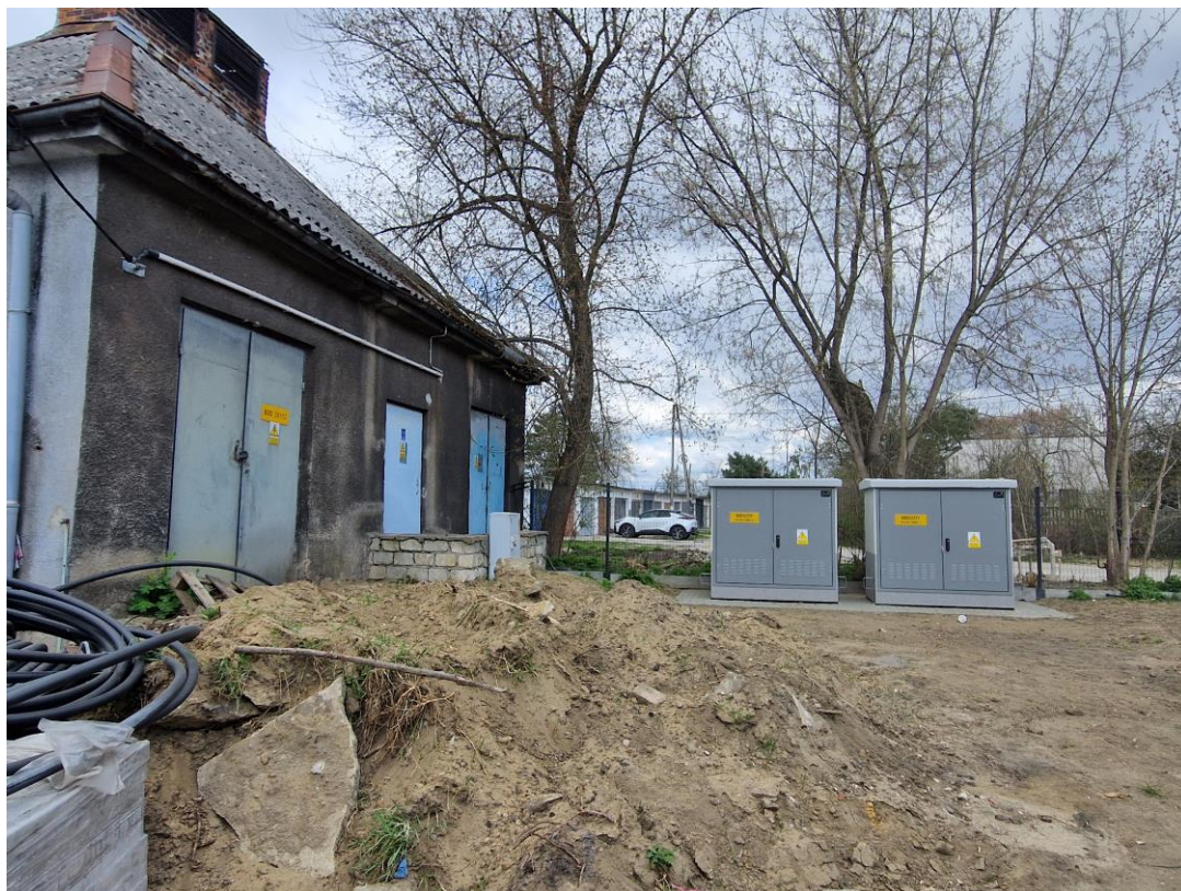
Fot. nr 11 – Po lewej budynek garażu z wejściem do starej rozdzielni głównej i stacji TRAFO. Po prawej stronie obiekty zasilania zrealizowane po stronie firmy Tauron zgodnie z warunkami.
