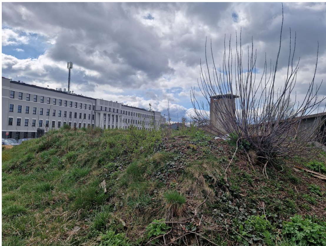
Fot. nr 5 – zbiornik wody wkopany w ziemię do usunięcia i utylizacji. Zbiornik i hydroforownia nie użytkowana. W zbiorniku po zdjęciu żeliwnych „dekli” zaobserwowano zanieczyszczoną wodę z materiałem biologicznym typu liście.
