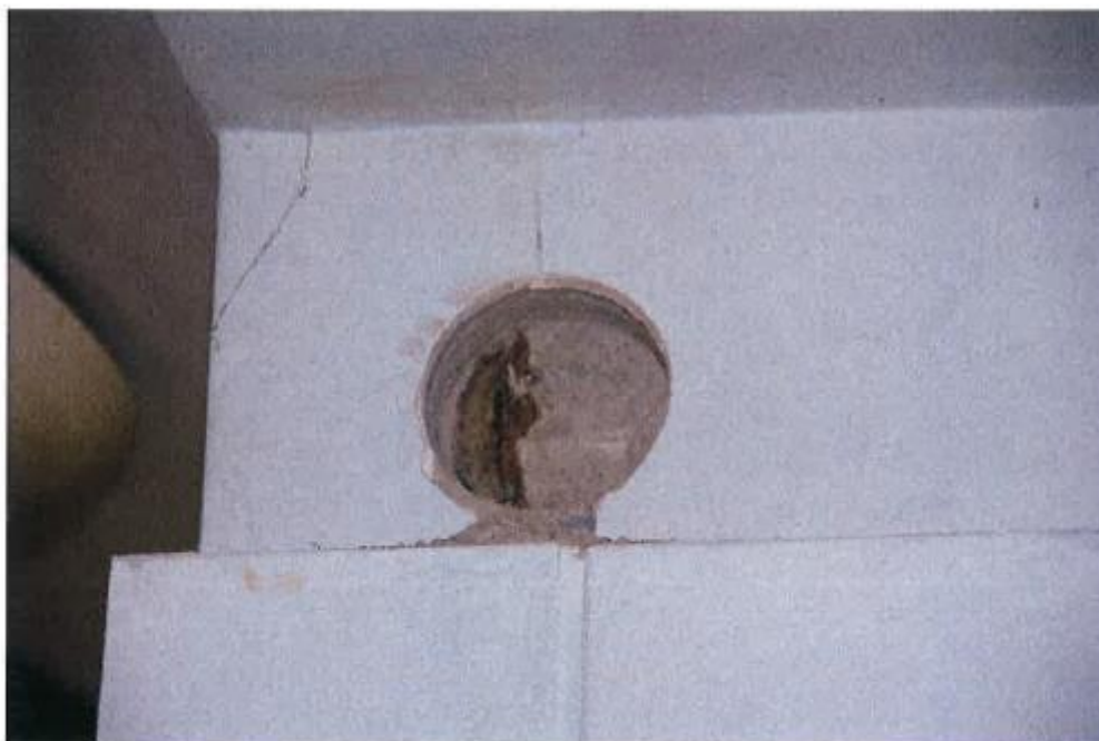
Fot. 3. Odkrywka nr 1. Na zdjęciu widoczna znaczna grubość tynku oraz powierzchnie skorodowany kątownik stanowiący zabezpieczenie naroża żelbetowej obójmy wzmacniającej słup.
