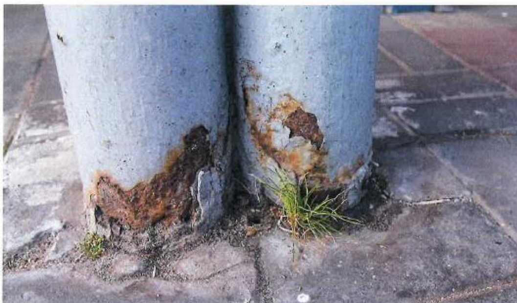
Fot. 8. Stan zachowania słupa nr 108 tuż nad kostką betonową
