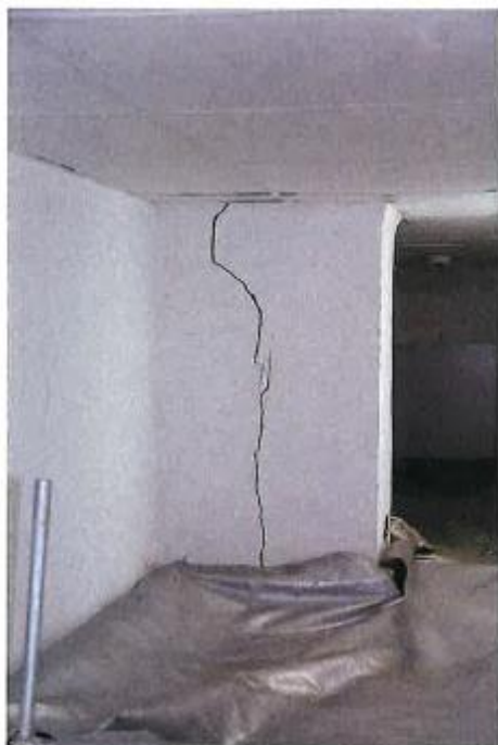
Fot. 4. Spekanie podłużne słupa w pompowni p.poż – widok od strony pomieszczenia.
