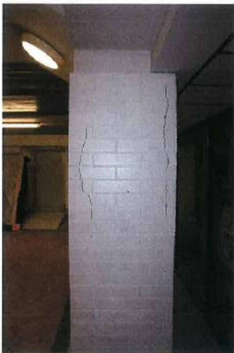
Fot. 1. Zarysowania i spekania podłużne widoczne na okładzinach słupów.
