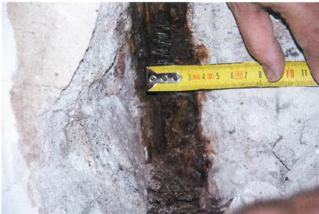
Fot. 7. Stan zaawansowanej korozji kątownika stalowego istniejącego słupa, stanowiącego wzmocnienie jego naroża.
