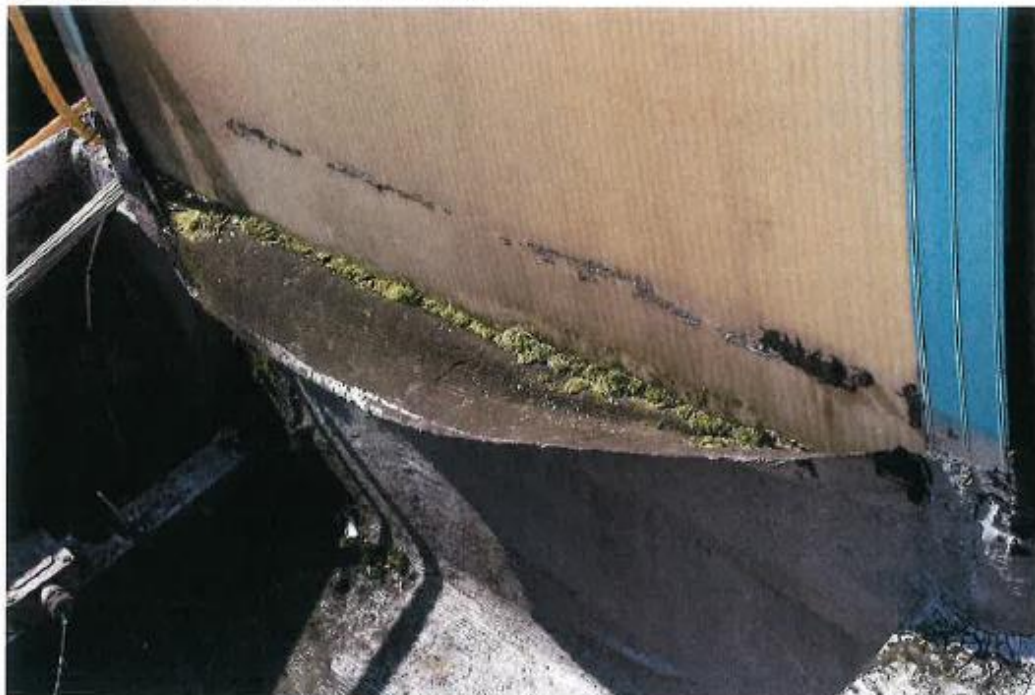
Fot. 1. Uszkodzenia izolacji przeciwwodnej w okapie zadaszenia łukowego
