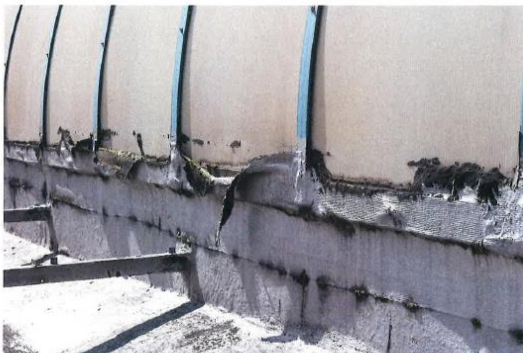
Fot. 2. Uszkodzenia izolacji przeciwwodnej w okapie zadaszenia łukowego
