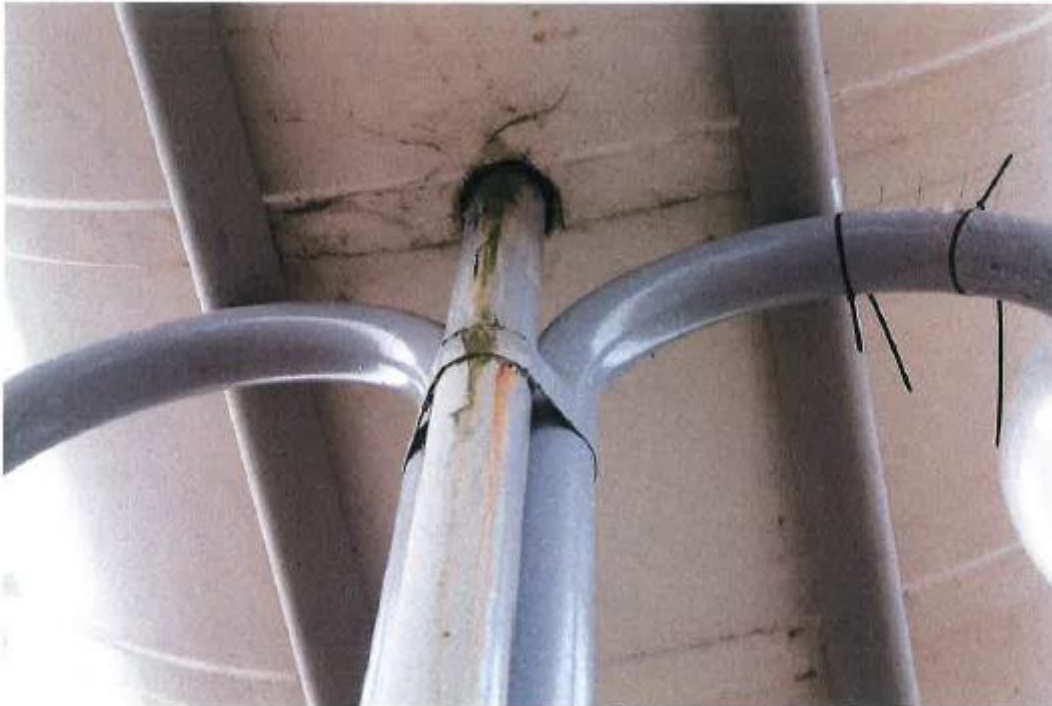
Fot. 11. Nieszczelności koryta ściekowego i zaciekający słup nr 76
