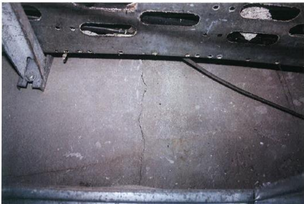
Fot. 9. Zarysowanie poszerzonego słupa w przestrzeni sufitu podwieszonego –przed odkrywką.
