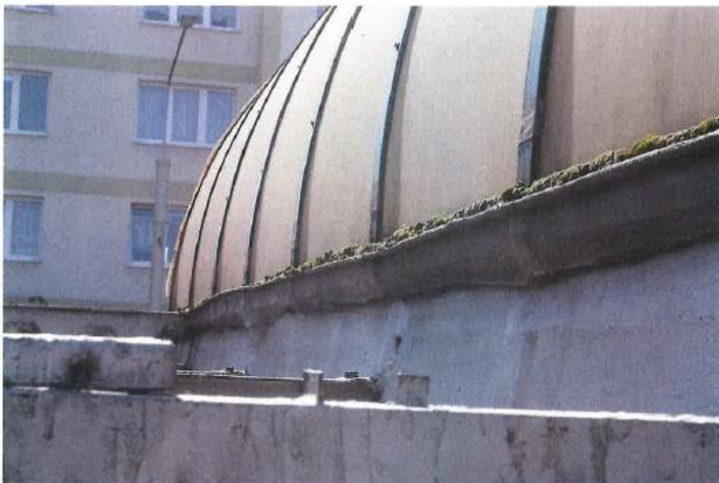
Fot. 3. Uszkodzenia izolacji przeciwwodnej w okapie zadaszenia łukowego
