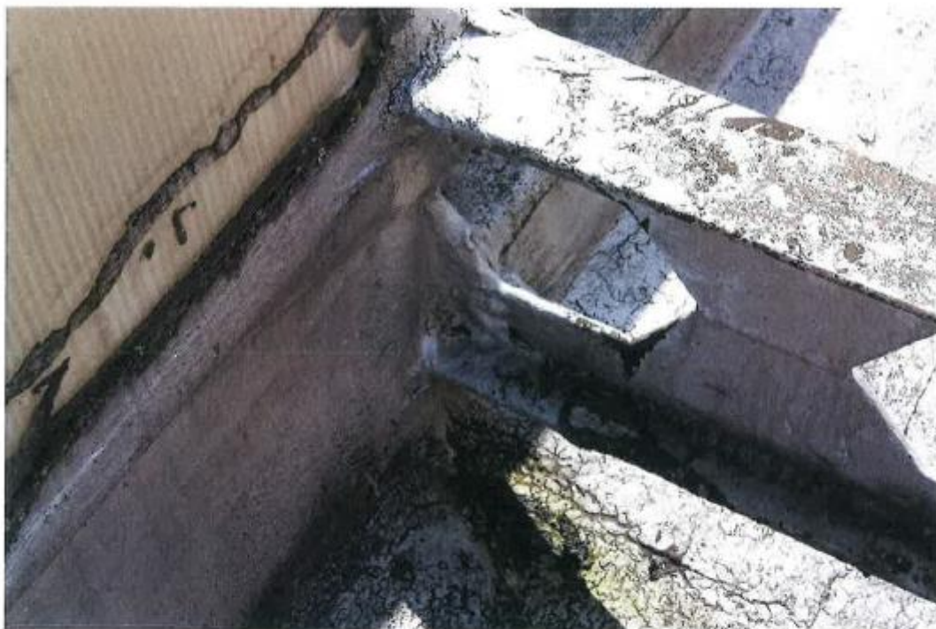
Fot. 7. Rygiel poprzeczny- sposób wykonania izolacji przeciwwodnej
