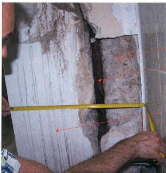
Fot. 6. Odkrywką nr 2 –słup w pompowni p. poż.
