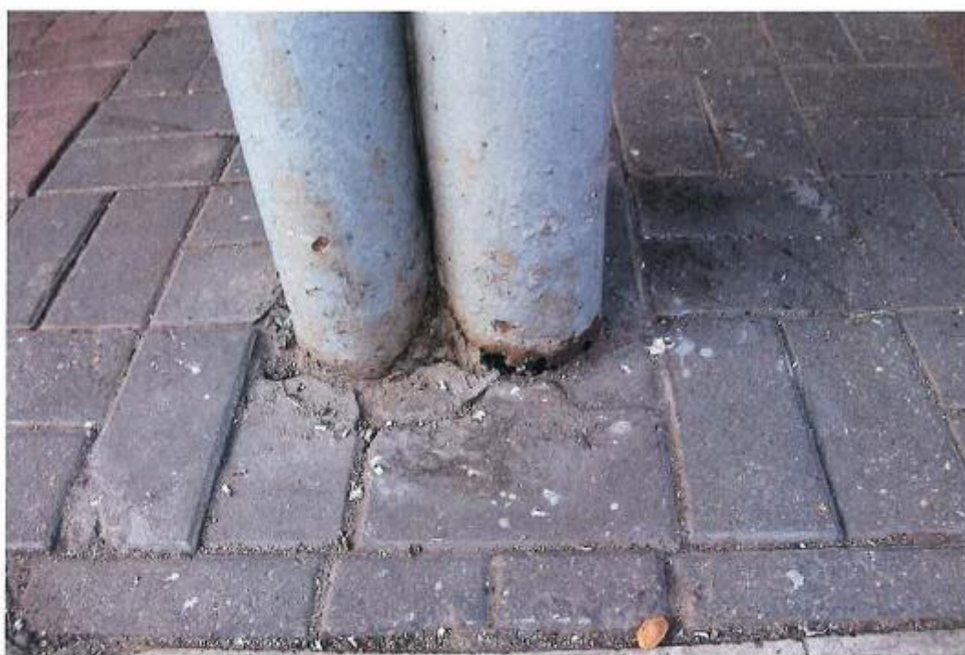
Fot. 10. Stan zachowania słupa nr 120 tuż nad kostką betonową
