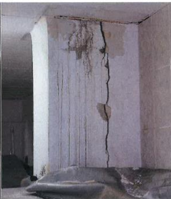
Fot. 5. Spekanie podłużne słupa w pompowni p.poż – widok od strony korytarza (drzwi zewnętrzne).
