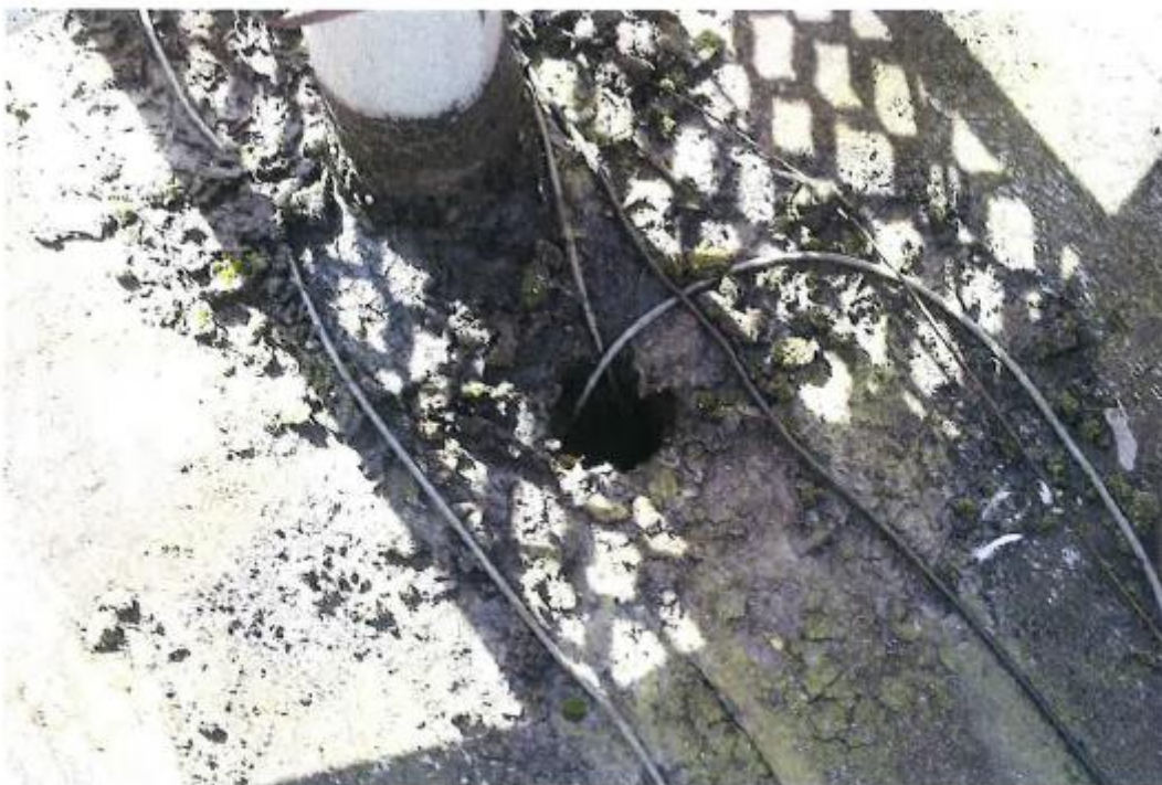
Fot. 5. Miejsce przejścia słupa przez koryto ściekowe oraz połączenie koryta z rurą spustową
