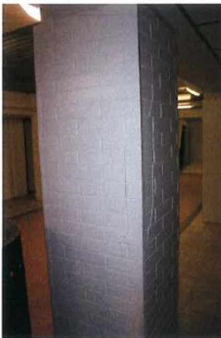
Fot. 2. Zarysowania i spekania podłużne widoczne na okładzinach słupów.
