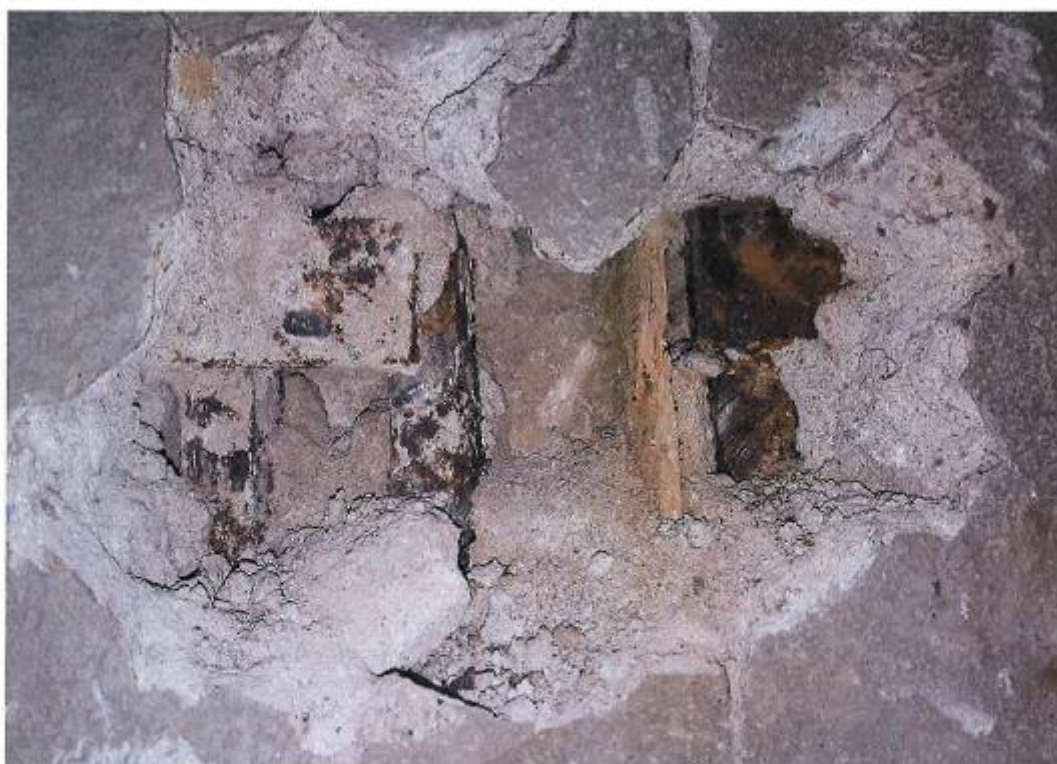
Fot. 10. Odkrywką nr 3 poszerzonego słupa. Widoczne pręty zbrojeniowe i płaskowniki obejmmy żelbetowej oraz przekładka dylatacyjna z płyty pilśniowej, zastosowana na styku dwóch elementów żelbetowych.
