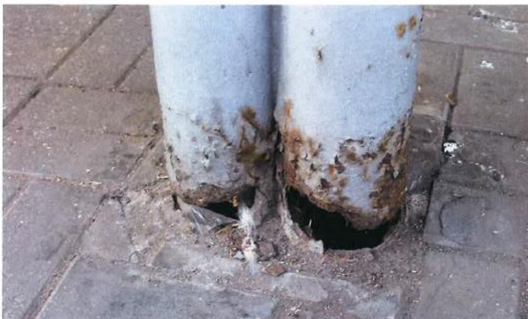
Fot. 9. Stan zachowania słupa nr 116 tuż nad kostką betonową
