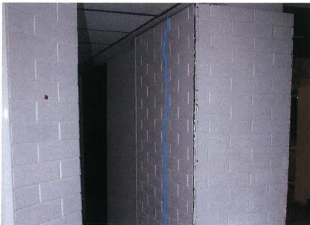
Fot. 8. Poszerzony słup w korytarzu głównym podziemia Hali Płaskiej. Zaznaczono przebieg zarysowania ściany bocznej.
