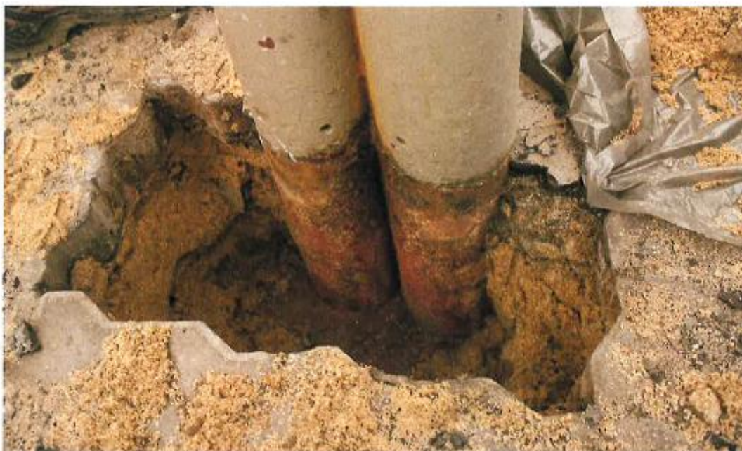
Fot. 12. Odkrywanie podstawy słupa nr 20
