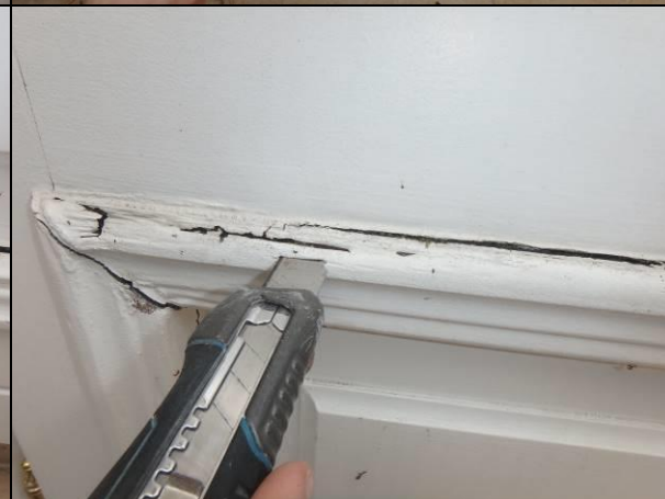
Fot. 39, 40. Przykładowe, występujące miejscowo zbutwiałe elementy drewniane
