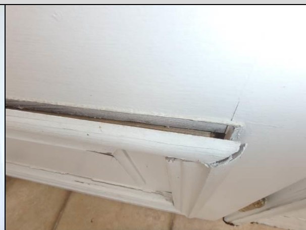
Fot. 41. Przykładowe uszkodzenie ramki mocującej ozdobną płycinę.
