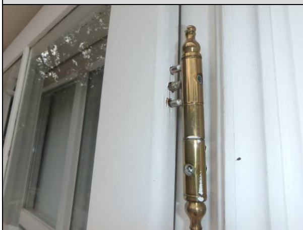
Fot. 41. Przykładowe pęknięcie ramy okiennej przy zawiasie.
