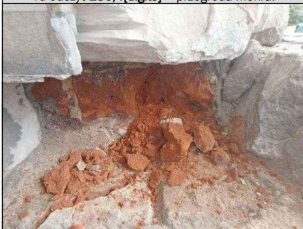
Fot_02_7. Cegła wymurowana pod podstawą słupa zmerszała, krucha, o obniżonych parametrach nośności.
