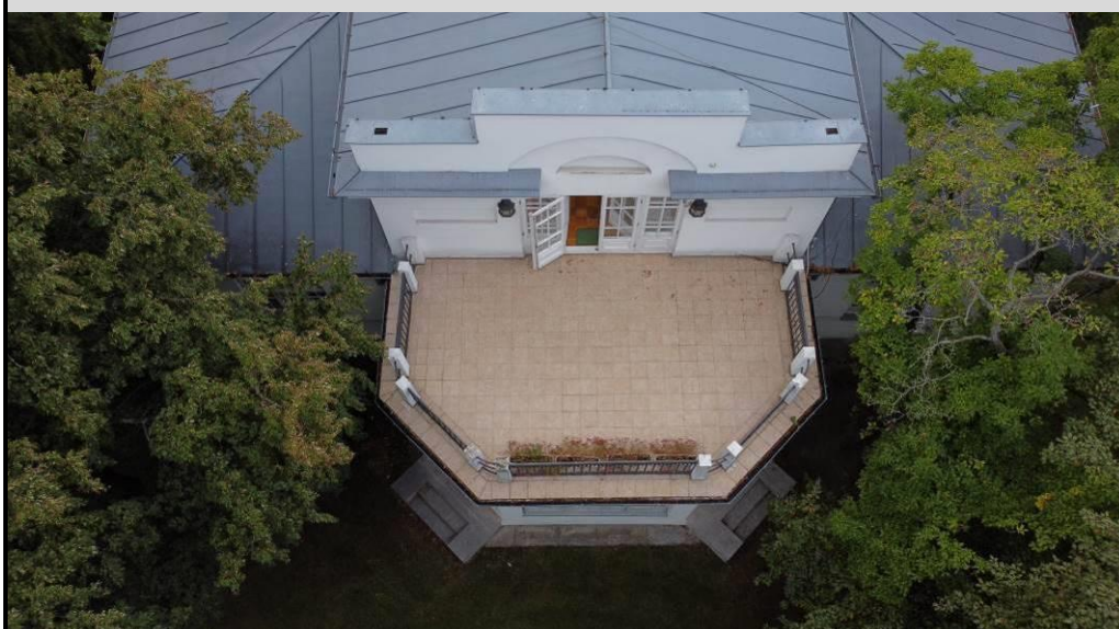
Fot_8, 9. Widok od frontu oraz od góry tarasu na elewacji północnej. Zachowana balustrada stalowa, pokryta wtórnymi warstwami malarskimi. Zachowane również betonowe słupki balustrady, pokryte wtórnymi warstwami wykończeniowymi. Warstwy wykończeniowe tarasu wtórne.
