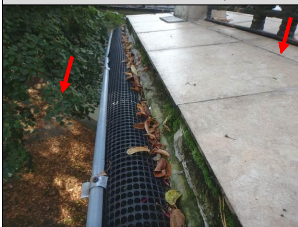
Fot. 27. Widok porastającej ze szlichty roślinności wskazującej na jej wysoki stopień zawilgocenia.
