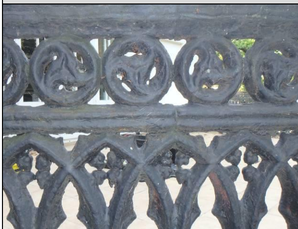
Fot. 29, 30. Balustrady wielokrotnie przemalowywane. Grubość powłok malarskich i ilości powodującej „wygładzenie” detalu architektonicznego.
