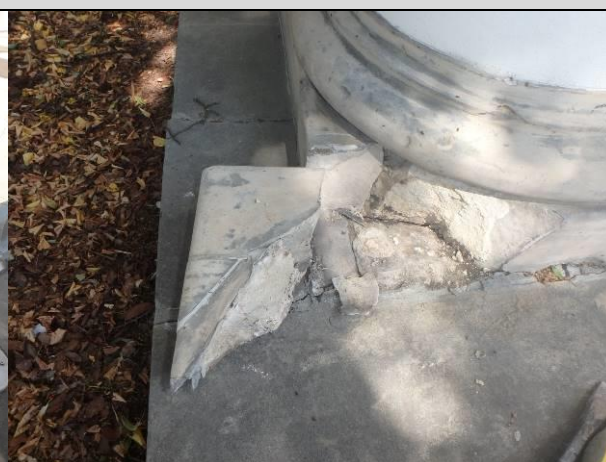
Fot_02_1, 02_2. Podstawa słupa z wyraźnymi pęknięciami strukturalnymi.
