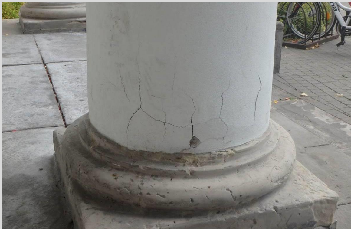
Fot. 16 i 17. Widok przykładowych warstw wykończeniowych na słupach konstrukcyjnych. Tynki w dolnych partiach w wielu miejscach spękane, zmurszałe, odpajające się od podłoża.
