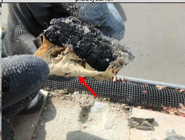
Fot 05_12. Pod izolacją bitumiczną stwierdzono obecność dodatkowej warstwy izolacji z „folii w płynie”.
