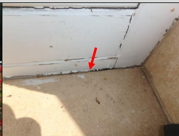
Fot. 32. Brak doszczelnienia strefy styku posadzki z drzwiami balkonowymi.
