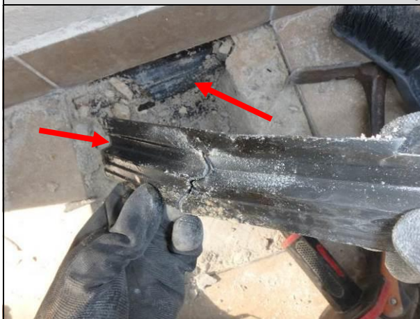
Fot. 04_7, 04_8. Pod szlichtą w narożniku wklęsłym stwierdzono profil z tworzywa sztucznego. Na profilu widoczne krople wody.
