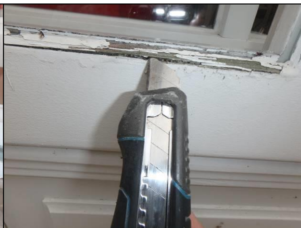
Fot. 43, 44. Przykładowe uszkodzenie ramki mocującej szybę okienną
