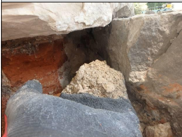
Fot_02_9, 02_10. Przykład całkowicie zwiertniętej spoiny.
