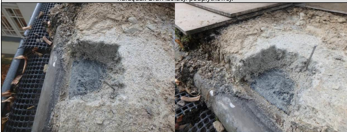
Fot. 03_3, 03_4. Pod płytką zbrojona szlichta cementowa niezabezpieczona izolacją podpłytkową. Szlichta widocznie zawilgocona.
