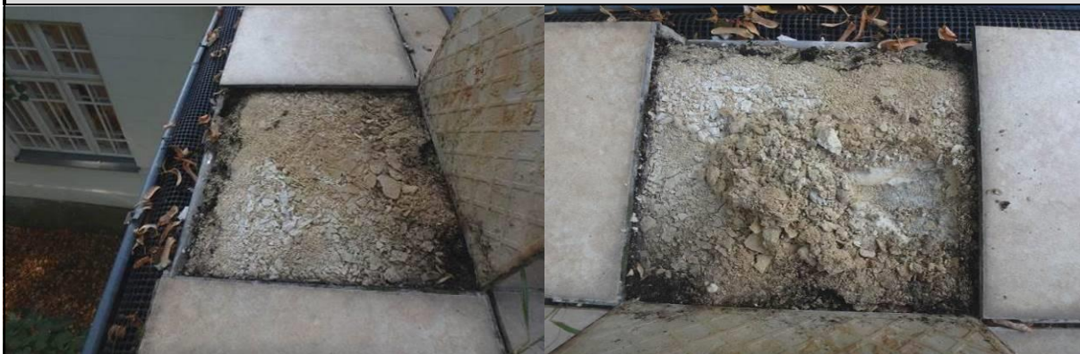
Fot 03_1, 03_2. Płytki wraz z zaprawą klejącą nienośna – możliwa do zdjęcia w całości bez użycia narzędzi. Brak izolacji podpłytkowej.
