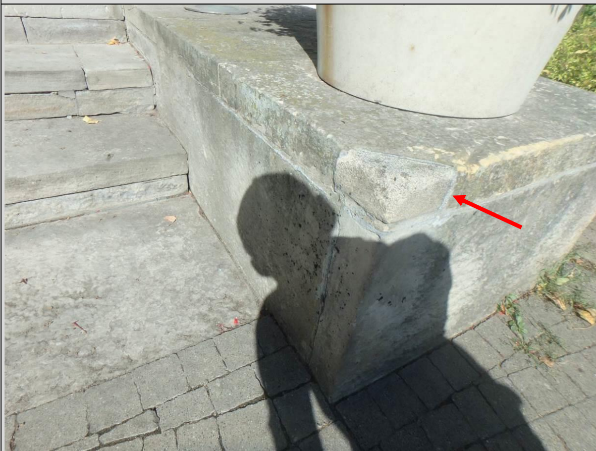
Fot. 21. Widok przykładowej naprawy płyty z piaskowca metodą flekowania.
