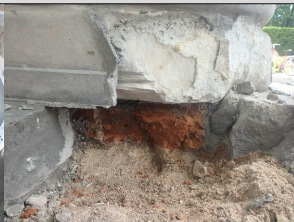
Fot_02_4. Kolor cegły silnie „brunatny”, co świadczy o wysokim stopniu zawilgocenia struktury muru.
