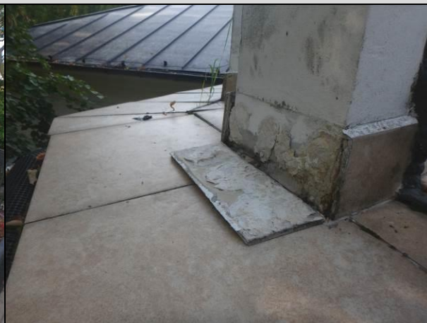
Fot. 24. Przykład odspojień płytki cokołowej
