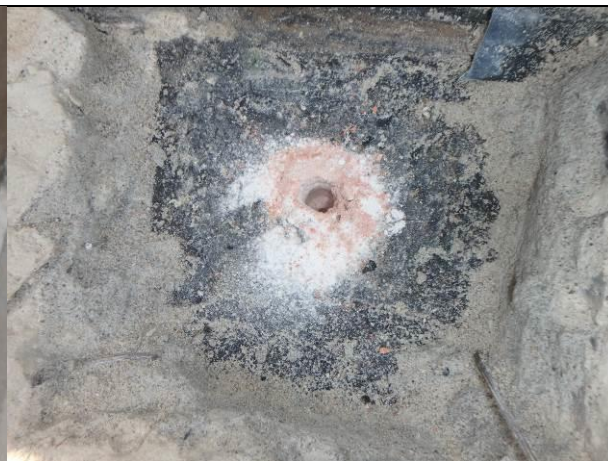
Fot 04_10. Pod izolacją bitumiczną czerwone zwierziny – najprawdopodobniej cegła stropu typu kleina.
