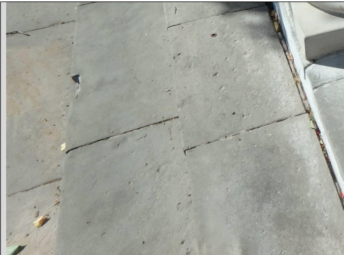
Fot. 20. Widok zanieczyszczonej, przebarwionej posadzki podestu/schodów zewnętrznych wykonanej z płyt z piaskowca. Na powierzchni płyt z piaskowca widoczne ubytki korozyjne.
