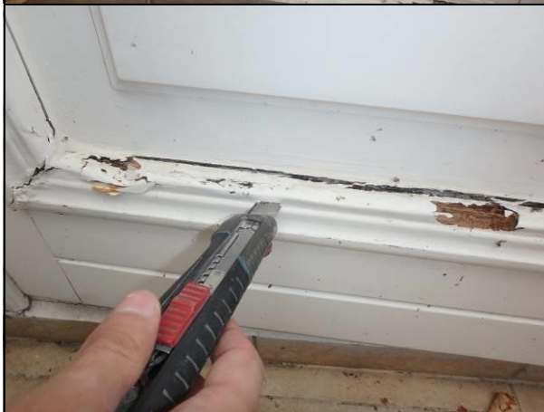
Fot. 39, 40. Przykładowe, występujące miejscowo zbutwiałe elementy drewniane
