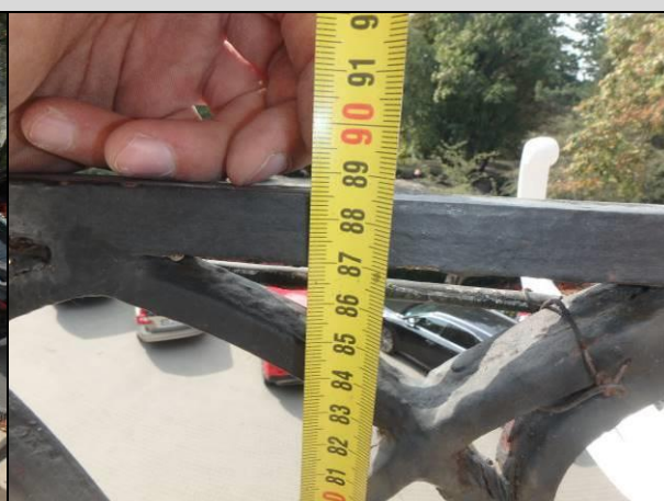
Fot. 37, 38. Wysokość balustrady ok 89cm.
