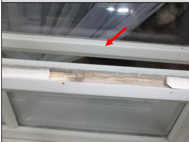
Fot. 41. Przykładowe ubytki kitu szklarskiego.
