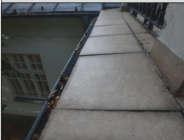
Fot. 25, Fot 26. Płytki w strefie krawędziowej możliwe do zdemontowania bez użycia narzędzi. Warstwa kleju oraz szlichty zdegradowana.
