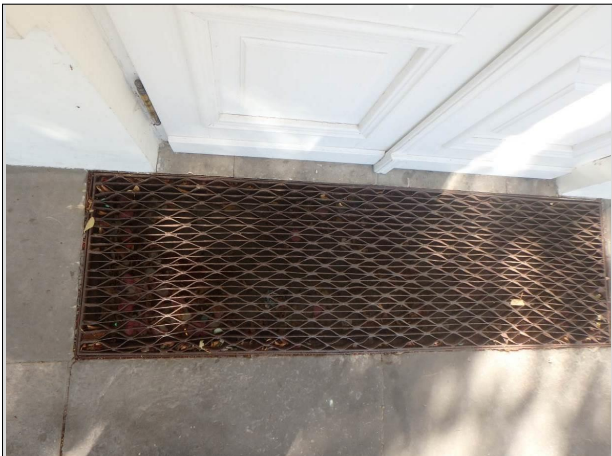
Fot. 22. Widok stalowej wycieraczki pokrytej korozją
