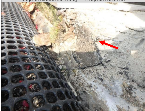
Fot. 05_11 Izolacja bitumiczna „wyprowadzona” na czoło szlichty – rozwiązanie uniemożliwiające prawidłowe odprowadzenie wody – nieprawidłowo.
