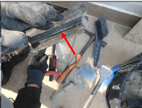
Fot. 04_7, 04_8. Pod szlichtą w narożniku wklęsłym stwierdzono profil z tworzywa sztucznego. Na profilu widoczne krople wody.
