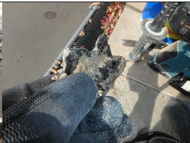
Fot. 05_10. Pod szlichtą zastosowano izolację z wątpliwej jakości masy bitumicznej – izolacja „miękka” w dotyku, wykazuje właściwości plastyczne.
