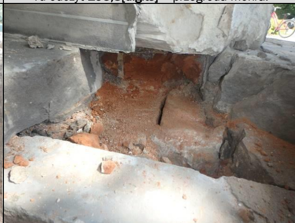
Fot_02_8. Spoiny cegieł w fundamencie miejscowo całkowicie wypłukane. Cegły fundamentu słupa nośnego miejscowo możliwe do wyjęcia bez użycia narzędzi.
