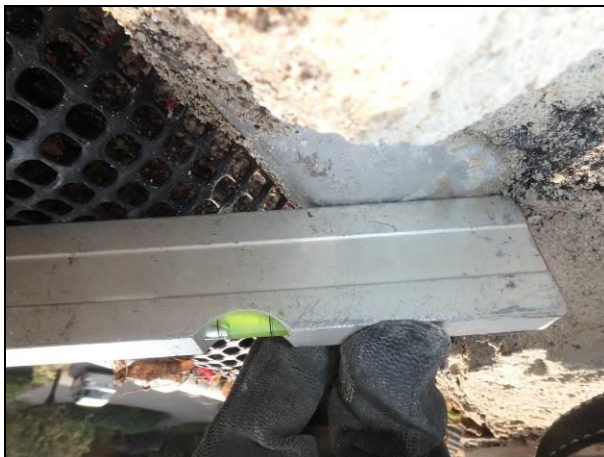
Fot 05_9. Krawędziowa obróbka blacharska wykonana ze spadkiem „do wewnątrz” budynku – rozwiązanie uniemożliwiające prawidłowe odprowadzenie wody – nieprawidłowo.
