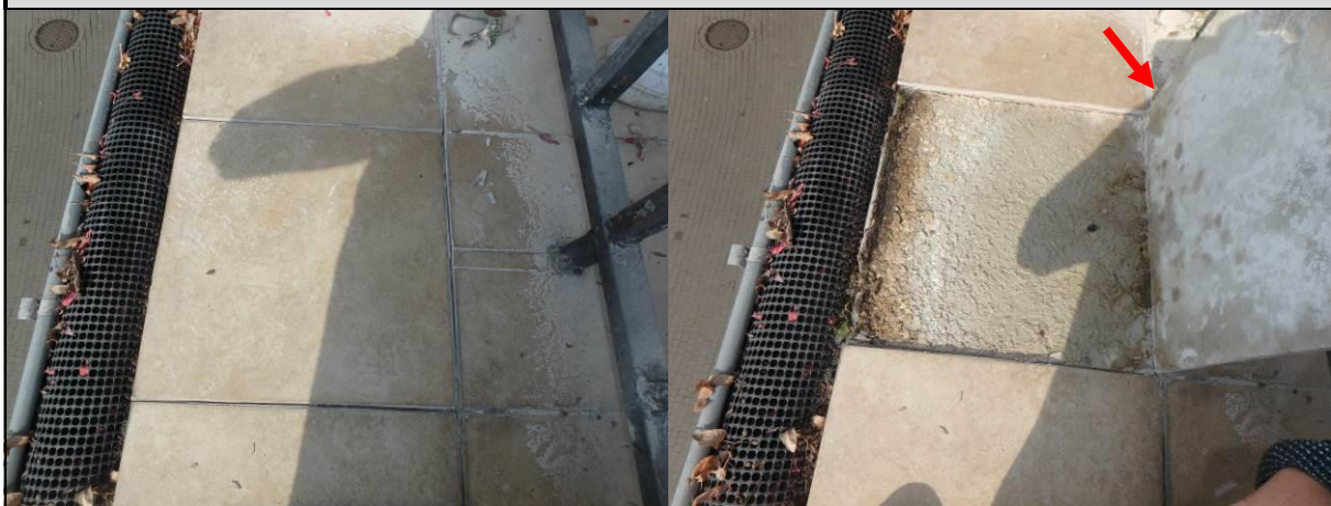
Fot. 05_1, 05_2. Płytki wraz z zaprawą klejącą nienośna – możliwa do zdjęcia w całości.
