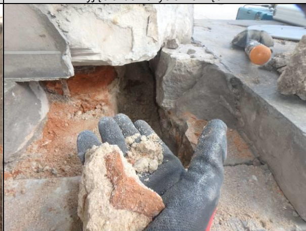
Fot_02_9, 02_10. Przykład całkowicie zwiertniętej spoiny.
