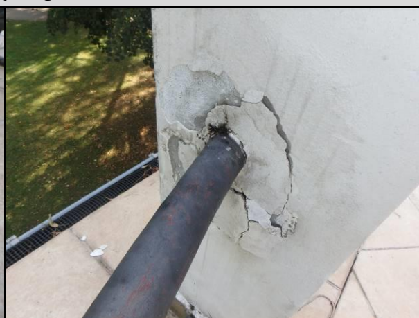
Fot. 28. Widok przykładowych odparzeń tynku na powierzchni słupka balustradowego
