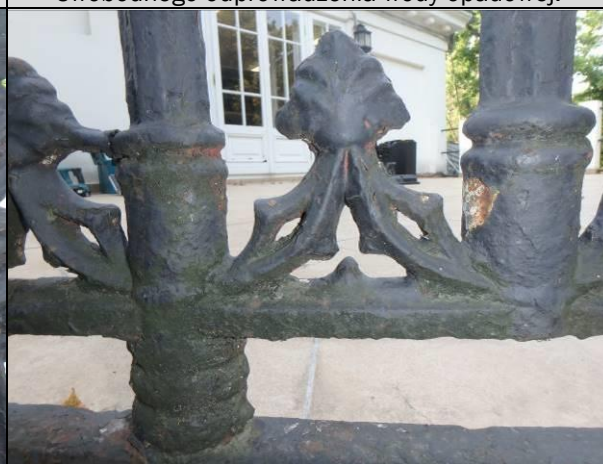
Fot. 29, 30. Balustrady wielokrotnie przemalowywane. Grubość powłok malarskich i ilości powodującej „wygładzenie” detalu architektonicznego.
