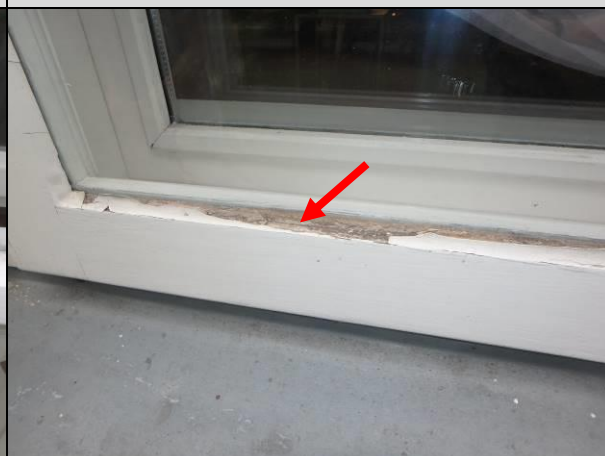
Fot. 41. Przykładowe ubytki kitu szklarskiego.
