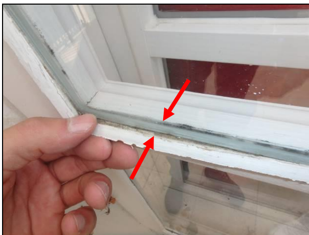
Fot. 43, 44. Przykładowe uszkodzenie ramki mocującej szybę okienną
