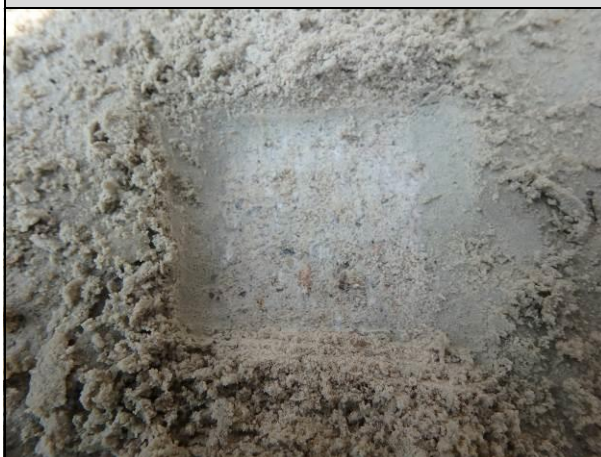
Fot 05_5. Pod płytką szlichta cementowa niezabezpieczona izolacją podpłytkową
