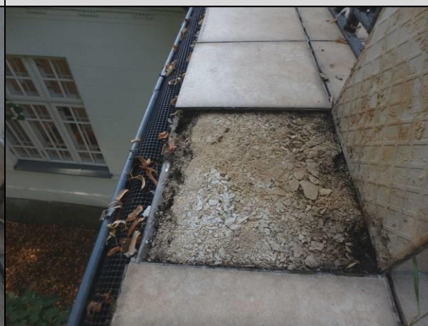
Fot. 25, Fot 26. Płytki w strefie krawędziowej możliwe do zdemontowania bez użycia narzędzi. Warstwa kleju oraz szlichty zdegradowana.
