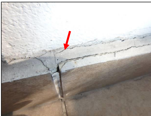
Fot. 33. Brak uszczelnienia na styku drzwi balkonowych z posadzką balkonu/tarasu.
