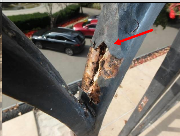
Fot. 35, 36. Balustrada balkonu z silnymi uszkodzeniami korozyjnymi
