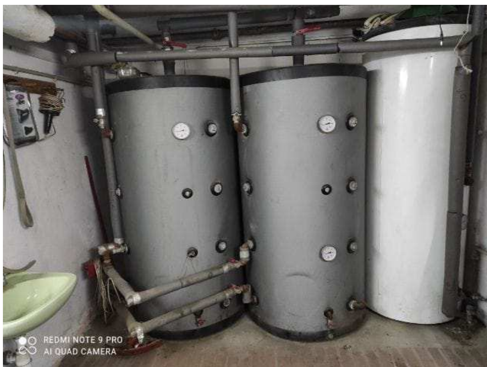
Rys. 5. Istniejące bufory i zasobnik CWU
