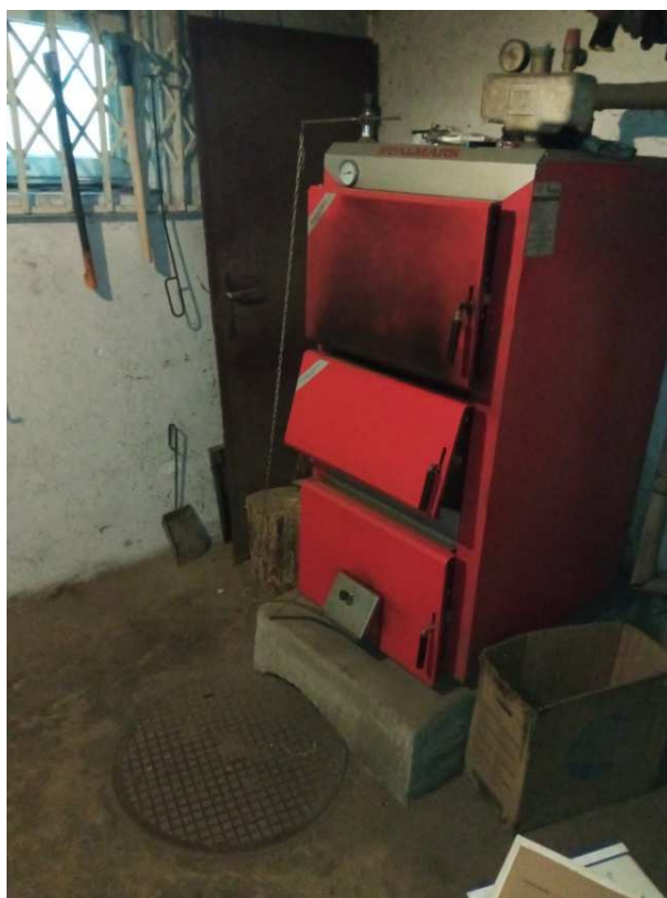
Rys. 3. Istniejący kocioł na paliwo stałe o mocy 38 kW
