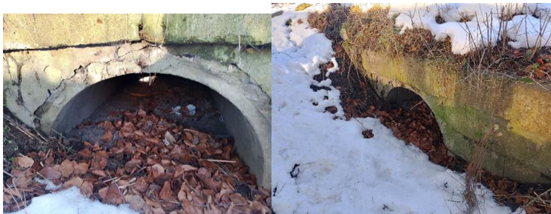
Zdjęcie ścianki czołowej przepustu.
