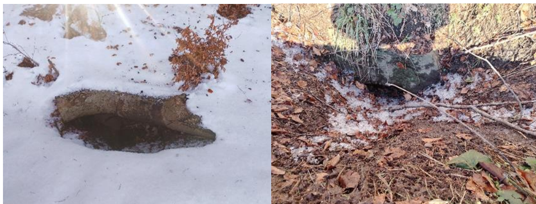
Zdjęcia przepustu kamiennego.
