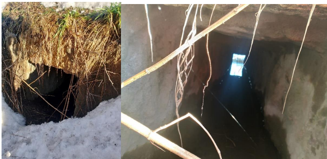
Zdjęcie wlotu do przepustu oraz elementu przelotowego.
