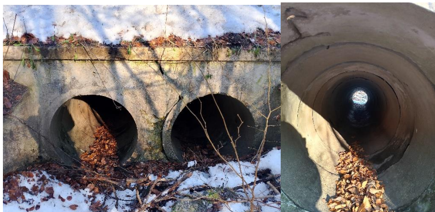
Zdjęcie ścianki czołowej przepustów oraz rury przelotowej.
