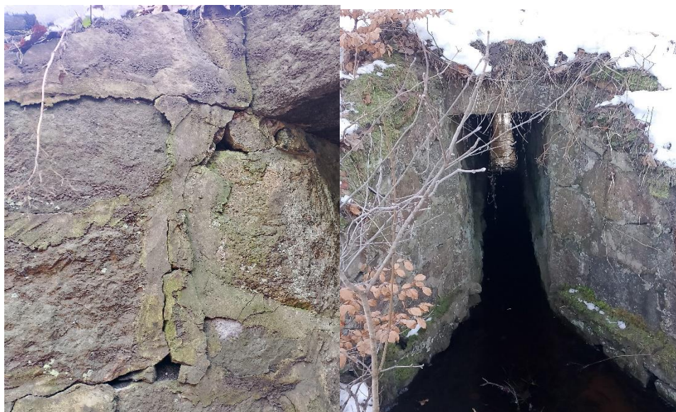
Zdjęcie skrzydła przepustu oraz wlotu do przepustu.
