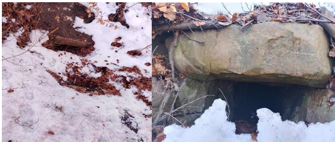
Zdjęcia przepustu kamiennego pod drogą.
