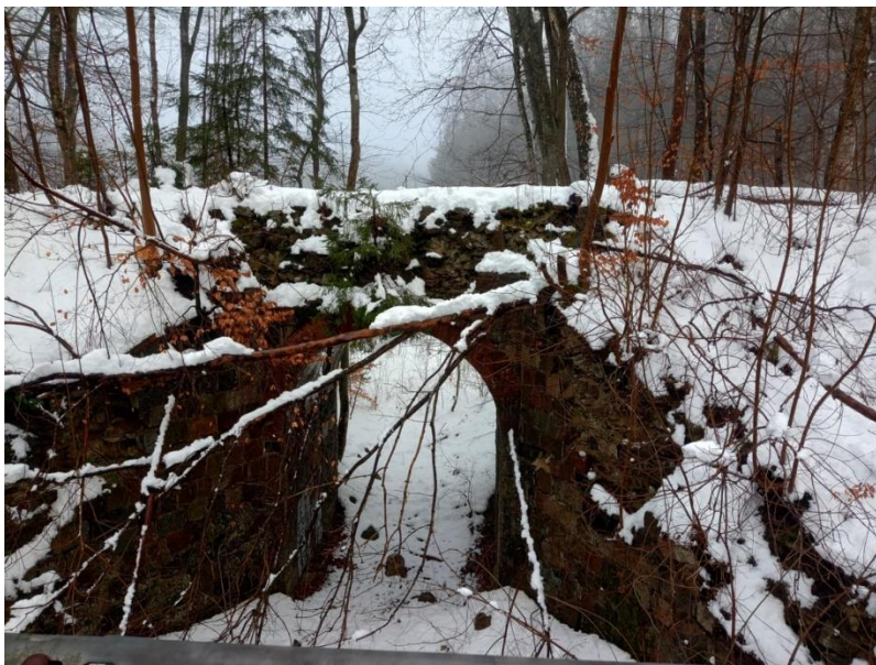
Zdjęcie wiaduktu kolejowego.
