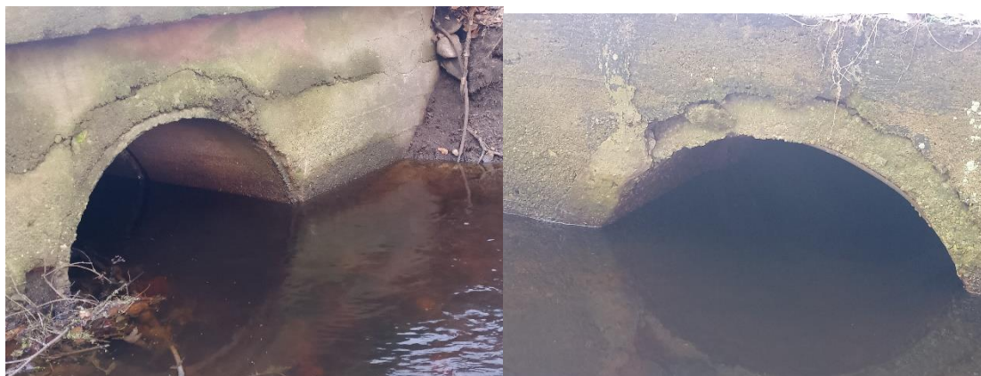
Zdjęcie ścianki czołowej przepustu.
