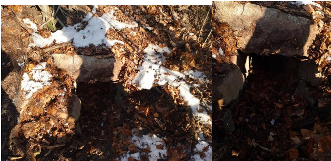
Zdjęcia przepustu kamiennego pod nasypem kolejowym.
